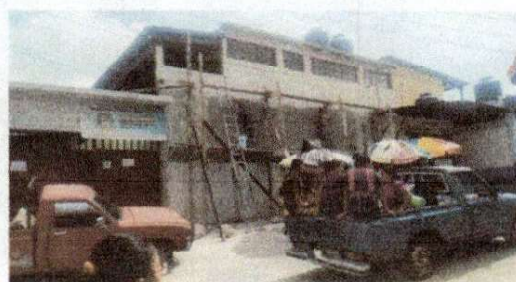
Foto 4: En esta imagen se muestra la pared c a trabajar en la entrada lateral de establecimiento sobre la 2a. Calle zona 2.
