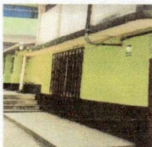
Foto 3: En esta imagen se muestra la pared B a trabajar en el primer nivel oficina Escuela de Comercio pared exterior: trabajo en proceso.
