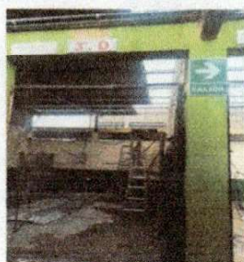
Foto 5: En esta imagen se muestra el salon 4 según croquis, con trabajos en proceso del levantado de techo para mejorar la ventilacion en salones de tercero básico Sección D.
