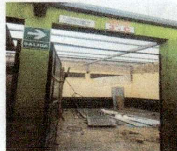
Foto 6: En esta imagen se muestra el salon 5 según croquis, con trabajos en proceso del levantado de techo para mejorar la ventilacion en salones de tercero básico Sección C.
