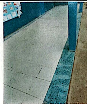
Foto 6: Piso remozado, corredores modulo 1.
