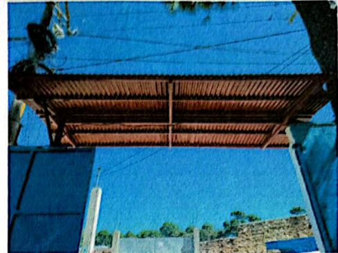
Foto 2: Porton, guías, rodos y techo remozados.
