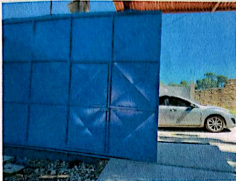
Foto 1: Porton con paneles inferiores y rieles remozados y rampa de cemento para proteger los mismos.
