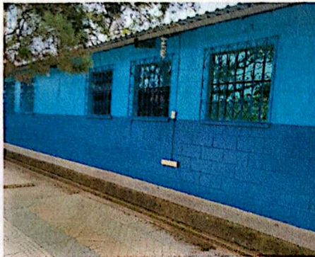
Foto 3: Pintura exterior de paredes remozadas, modulo 2.
