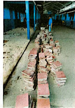
Foto 4: Levantado de piso deteriorado. Modulo 1,
