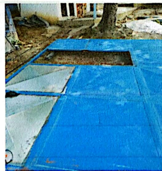
Foto 6: Fabricación puerta de paso, porton del campo
