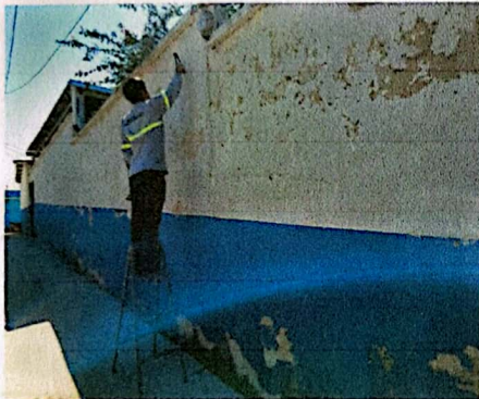
Foto 3: Limpieza de paredes antes de pintarlas, area externa de la escuela.
