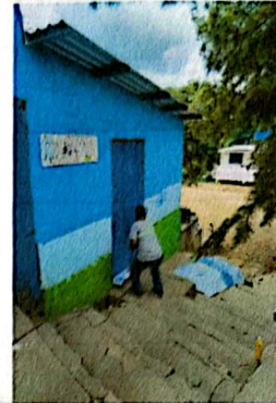
Foto 2: Aplicación de pintura anticorrosiva en puertas.
