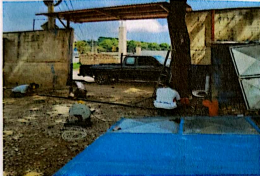
Foto 1: Realización de trabajos cambio paneles inferiores podridos y rieles.
