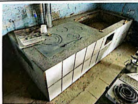
Foto 5: Construcción de estufa para leña con su respectiva plancha y chimenea.
