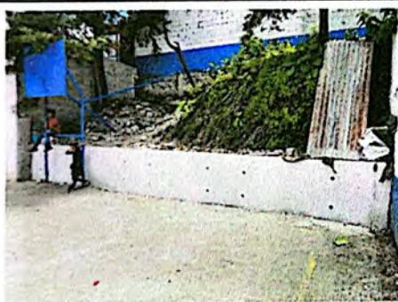
Foto 3: Muro de mampostería reforzado.
