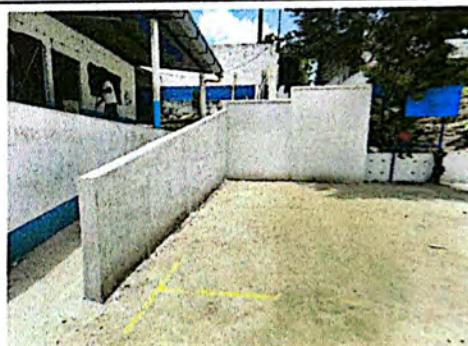
Foto 4: Rampa de acceso a salones
