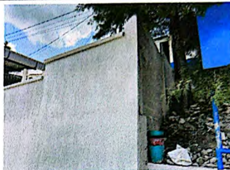
Foto 2: Muro de contención reforzado.
