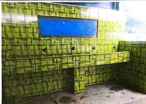
Foto 7: Suministro e instalación de azulejo en pileta tipo lavamanos.
