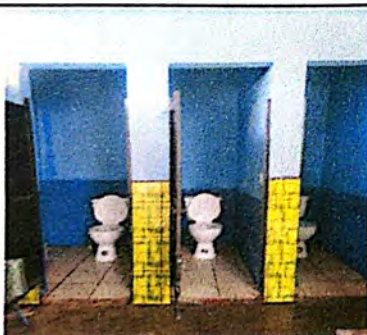
Foto 9: Instalación de inodoros + aplicación de pintura + instalación de azulejo.
