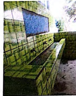
Foto 8: Instalación de azulejo en pileta tipo lavamanos.
