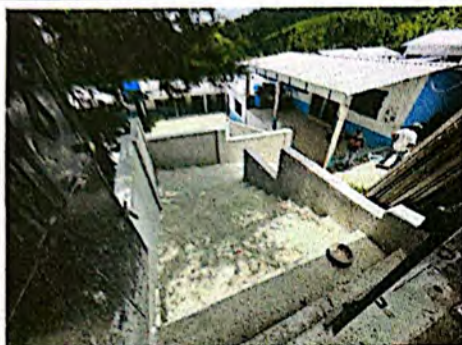
Foto 1: Construcción de gradas de acceso al establecimiento.
