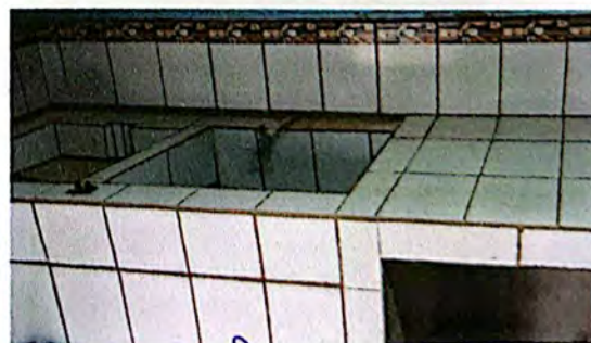
Foto 6: Fabricación de pileta, con azulejo.
