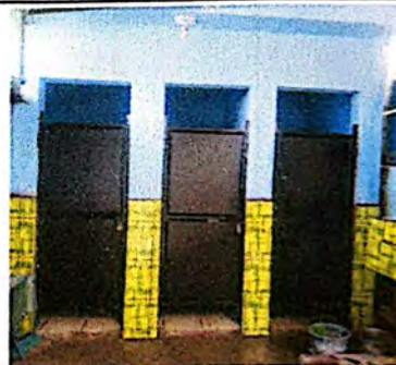
Foto 10: Mantenimiento de puertas metálicas de sanitarios, incluye lijado y pintura.
