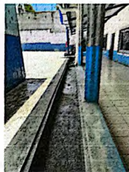
Foto 8: Fabricación de cuneta para descarga pluvial, la cuál evitará que el agua se derrame al pasillo.
