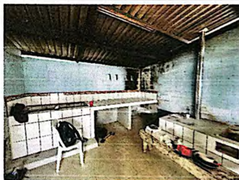
Foto 10: Construcción de mesa de trabajo.
