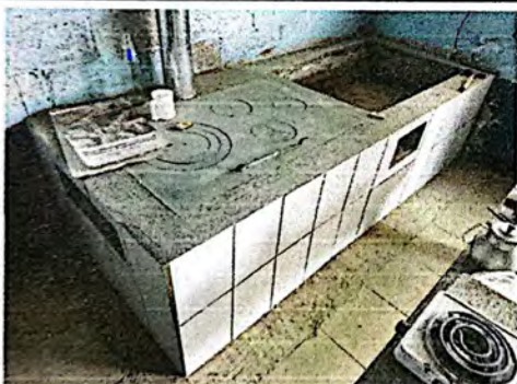
Foto 9: Construcción de estufa con mampostería con su respectiva chimenea forada en azulejo.
