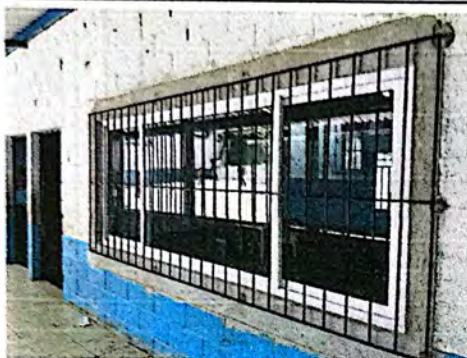
Foto 7: Ampliación de vano para ventana + suministro e instalación de ventanería UPVC.
