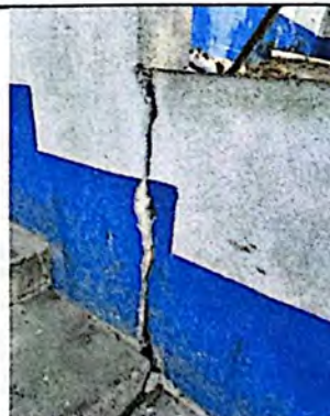
Foto 4: Fisuras en muro que delimita el módulo de gradas, el cuál se encuentra a punto de colapsar.
