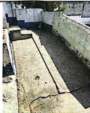
Foto 2: Se pueden apreciar las fisuras en la rampa de acceso.
