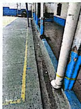
Foto 10: Actualmente en épocas de lluvia se inunda el pasillo de los salones debido a que no es suficiente el canal que se tiene, por lo que se deberá fabricar una cuneta, con su respectiva rejilla.
