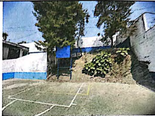
Foto 8: En este punto se deberá realizar un muro de contención de 1 metro de altura, para evitar que la tierra que se desprende se riegue en la cancha.
