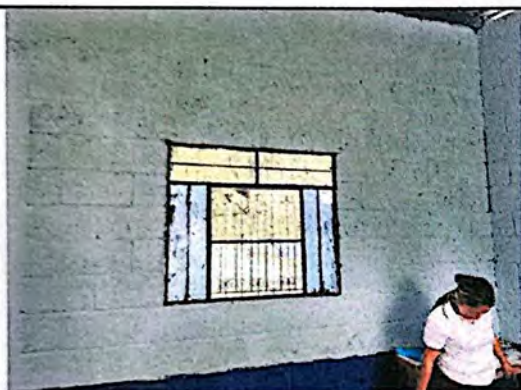
Foto 9: El tamaño de las ventanas, no permite tener una buena iluminación y ventilación en el salón de clases.
