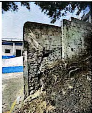
Foto 3: El muro de contención de las gradas se encuentra fuertemente afectado por lo que es un riesgo para los estudiantes.
