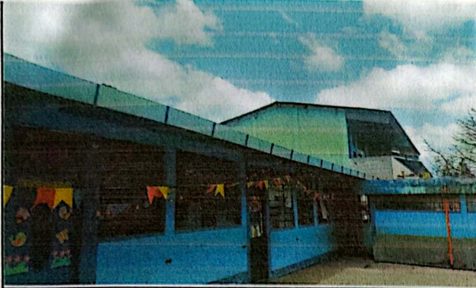
Foto 1: Instalado canal de salones en el primer nivel.
