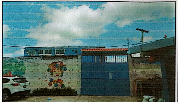
Foto 4: Instalado portón lateral de la escuela con estructura de techo a dos aguas.
