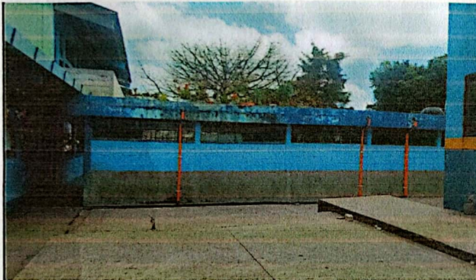
Foto 3: Instalado bajadas de agua con tubo PVC anaranjado.
