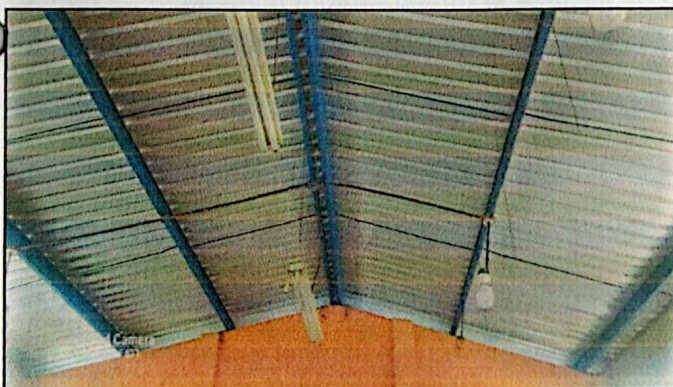
Foto 5: Instalada lámina de los salones del segundo nivel.
