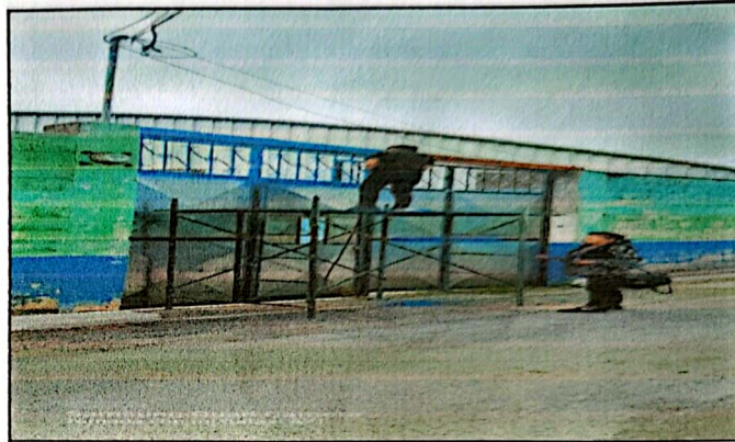
Foto 4: Revisando los trabajos del cambio de portón lateral de la escuela.
