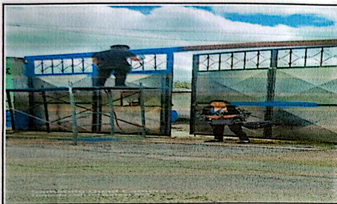
Foto 3: Cambio de portón lateral de la escuela.
