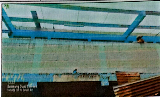
Foto 2: Desmontaje de lámina de salones del segundo Nivel.
