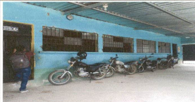
Foto 10: Las ventanas del salón de cuarto primaria y dirección están deterioradas por tener más de 55 años de antigüedad, necesitan ser sutituidas por ventanas PVC corredizas.
