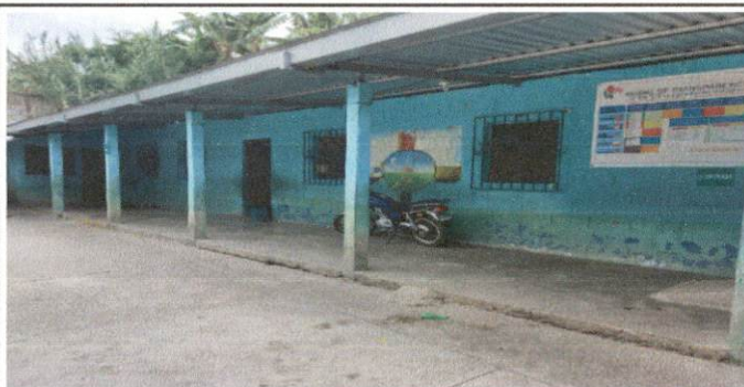
Foto 11: Las ventanas de 1ro, B, tercero y quinto están deterioradas por tener más de 55 años de antigüedad, necesitan ser sutituidas por ventanas PVC corredizas.
