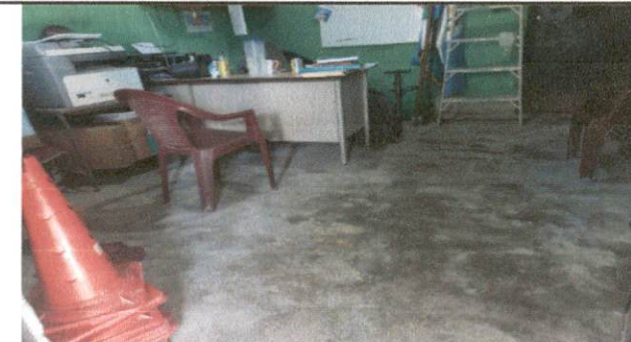
Foto 6: El piso de la dirección del establecimiento se encuentra en mal estado, por lo que se le colocará piso de duela cerámica.
