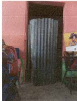
Foto 14: La puerta de lámina de la bodega que tiene ingreso por el aula de cuarto primaria debe ser sustituida por una puerta metálica con chapa.
