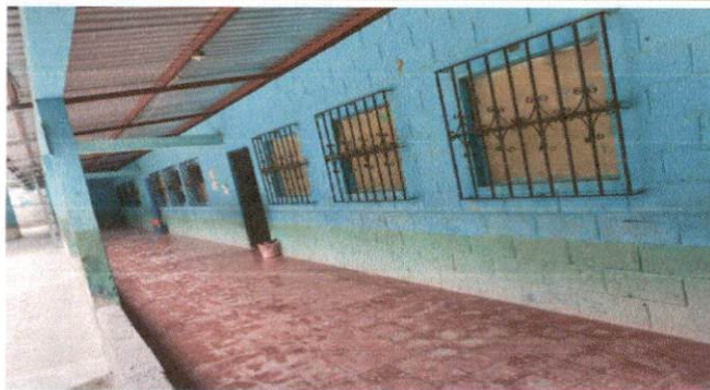
Foto 7: Las ventanas de la parte del frente de prepa, 1ro., 6to. están deterioradas por tener mas de 55 años de antigüedad, necesitan sustituirse por ventanas de PVC corredizas.
