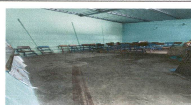
Foto 4: El piso del aula de Tercero primaria no es el adecuado, ya que se encuentra rajado por el paso de los años por lo que se le colocará piso de duela cerámica.
