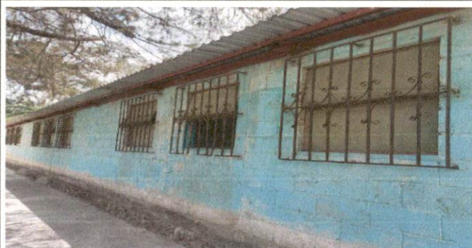
Foto 8: Las ventanas de la parte de atrás de prepa, 1ro., 6to. están deterioradas por tener mas de 55 años den antigüedad, necesitan sustituirse por ventanas de PVC corredizas.
