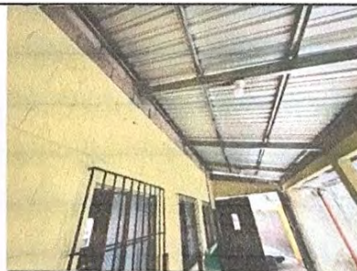
Foto 6: Cambio de estructura y lamina existente y red electrica
