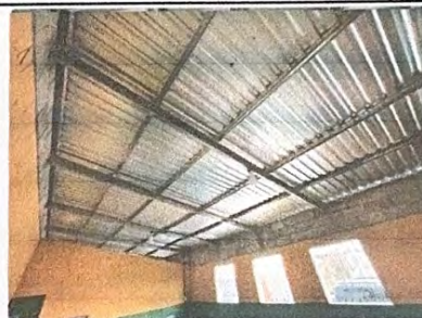
Foto 4: Cambio de estructura y lamina existente
