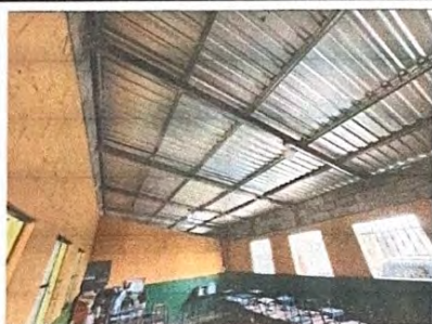
Foto 3: Cambio de estructura y cubierta
