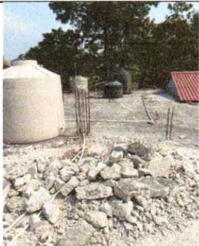
Foto 3: Levantamiento de mezclón para mejoramiento de losa
