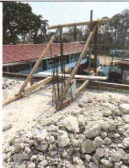
Foto 5: Polea que utilizaron los albañiles para bajar el ripio extraído de los pañuelos antiguos, los cuales estaban en malas condiciones
