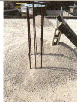
Foto 6: Mezcla de arena y piedrín lista para ser mezclada con agua y así obtener cemento
