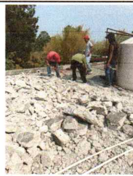
Foto 4: Levantamiento de mezclón para mejoramiento de losa
