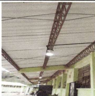
Foto1: .Instalación de focos en los corredores
