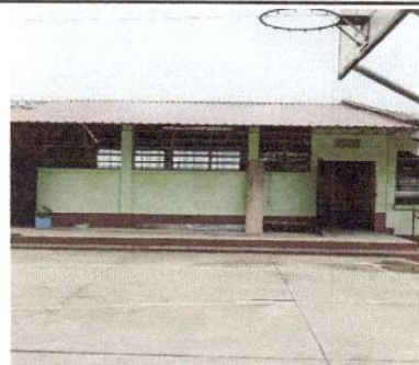
Foto 4: Avance de la colocación de lámina troquelada
