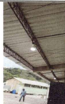
Foto 2: Camcio de cables en el corredor
