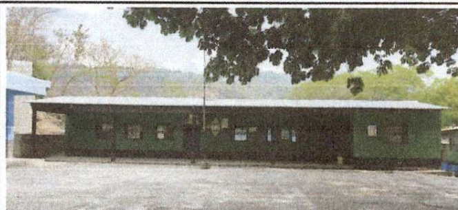
Foto 2: se muestra obra finalizada de los salones 3, 4 y 5
