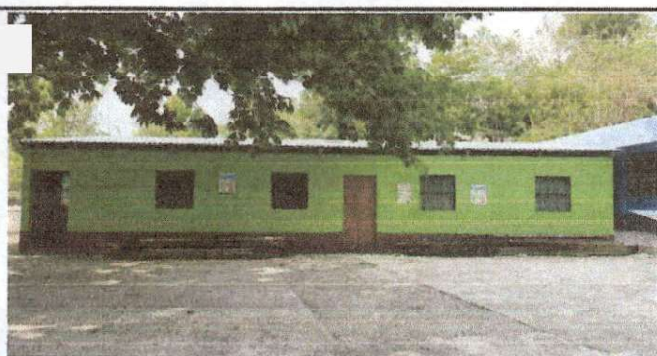
Foto 5: Se muestra la obra finalizada de los salones 1 y 2.
