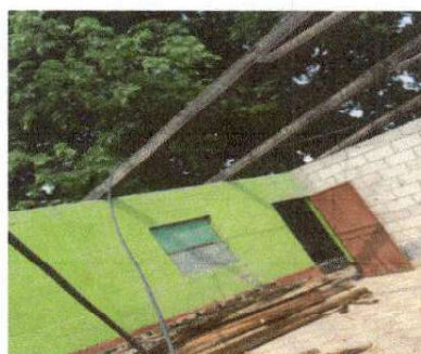
Foto 4: Se muestra que en los salones 1 y 2 se retiró el techo.
