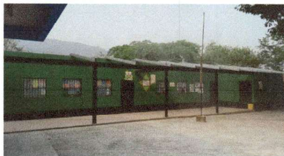
Foto 2: Se muestra el inicio de la obra en los salones 3, 4 y 5
