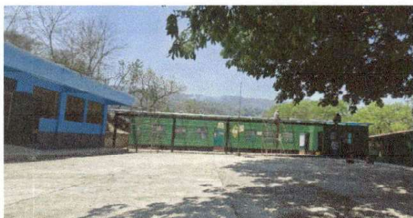
Foto 3: Se muestra el avance de cambio de techo en los salones 3, 4 y 5
