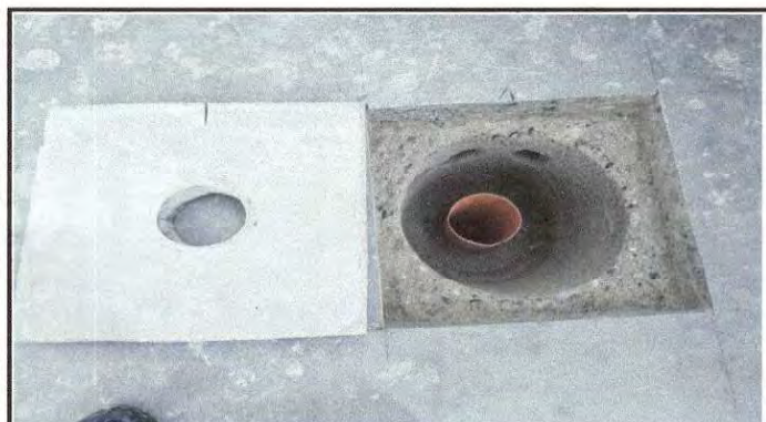
Foto 3: Reparación de tubería de agua y de drenaje.
