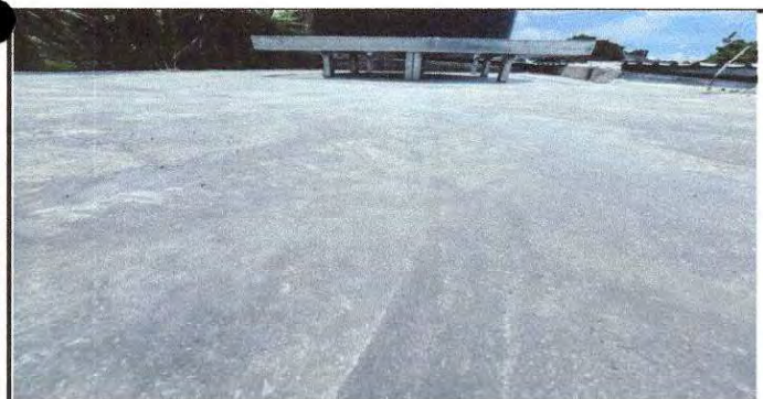
Foto 5: Impermeabilización de losa bodega de alimentos.
