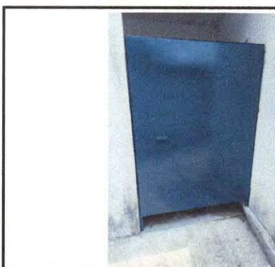
Foto 10: Sustitución e instalación de puerta para sanitario (para niños con capacidades especiales)
