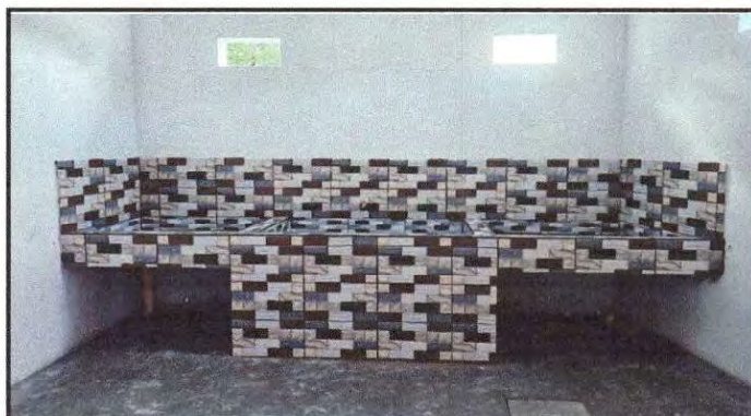
Foto 4: Sustitución de pila por pila de cemento de dos lavadero, con azulejo interiores y exterior.
