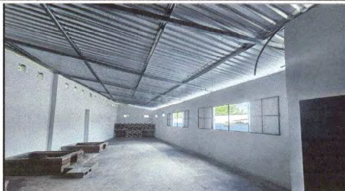
Foto 2: Sustitución de pared de block en mal estado por nueva y cernido de pared de cocina.
