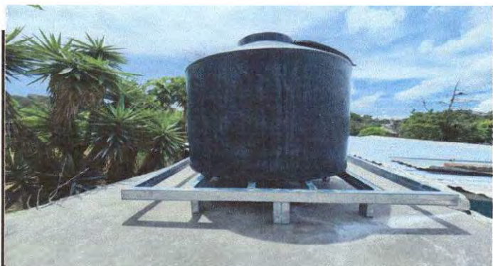
Foto 11: Reparación de depósito de agua (base de tubo de metal)
