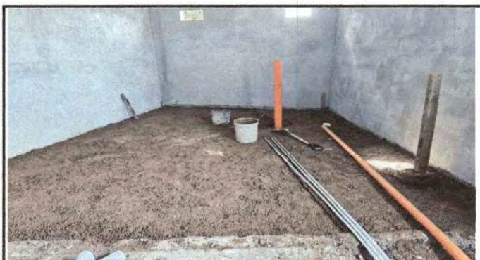
Foto 12: Reparación de piso de torta de concreto cocina
