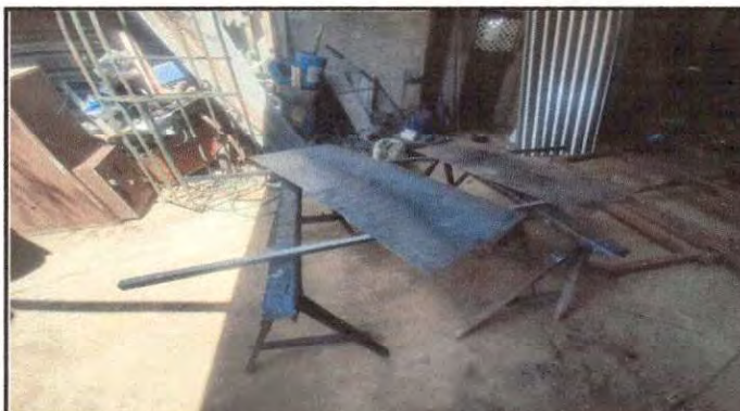
Foto 10: Sustitución e instalación de puerta para sanitario (para niños con capacidades especiales)
