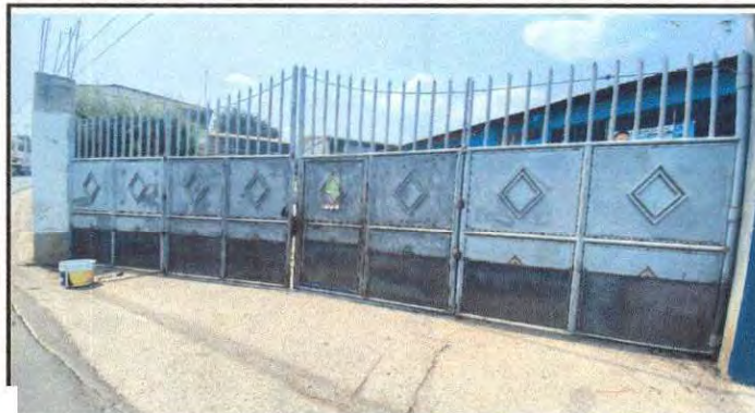
Foto 7: Mantenimiento de portón (lijado, cepillado, cambio de tubo y lamina, aplicación de pintura)
