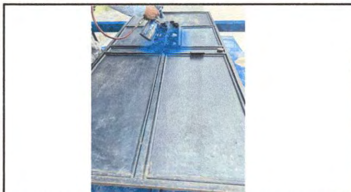
Foto 9: Mantenimiento a estructura de metal de 2 puertas (lijado y pintado)
