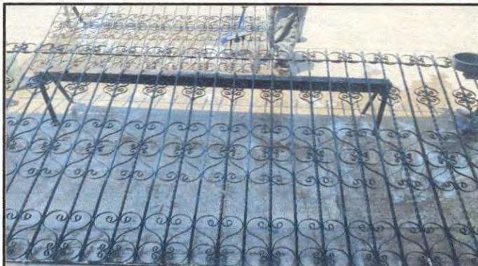
Foto 8: Mantenimiento a estructura de metal de balcones (lijado y pintado)
