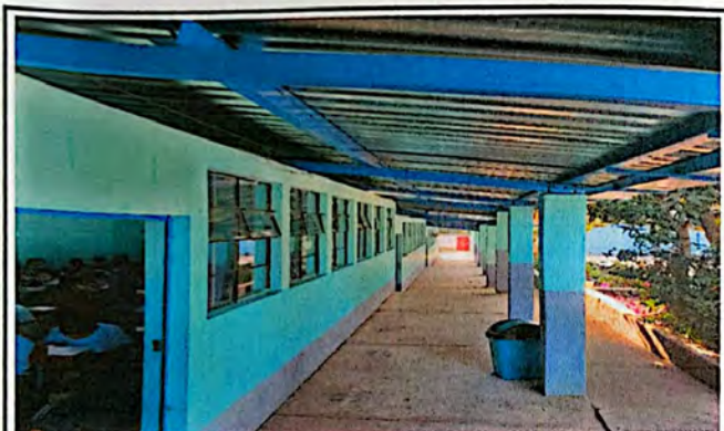
Foto N 3: Instalación de lámina, mantenimiento y pintura en estructura metálica de aulas y corredores del lado derecho de la escuela.
