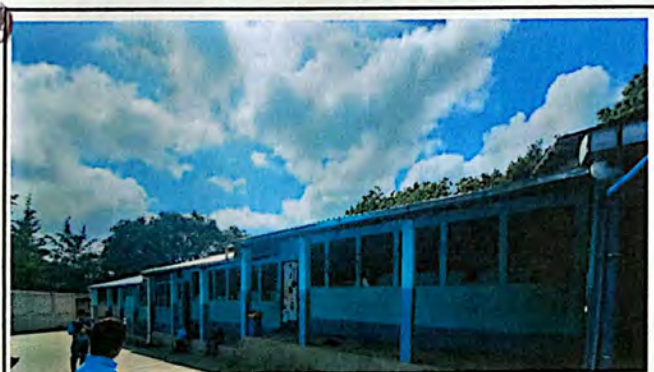
Foto N 5: Instalación de lámina y mantenimiento en salones de clase lado izquierdo de la escuela.
