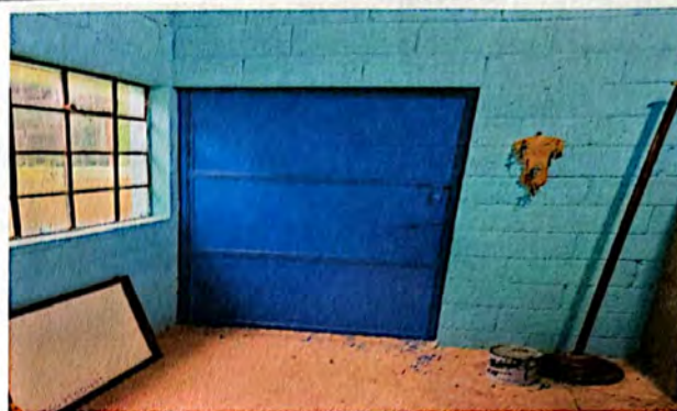
Foto N 8: Aplicación de pintura anticorrosiva a puerta de Dirección.
