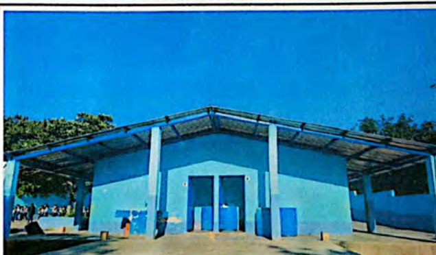
Foto N 6: Instalación de lámina, mantenimiento y pintura a estructura de metal area de sanitarios.
