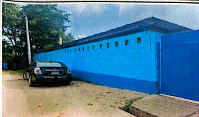
Foto N 7: Aplicación de pintura en pared de entrada de la escuela.
