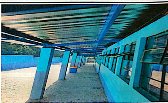
Foto N 4: Instalación de lámina, mantenimiento y pintura de estructura metálica de aulas y corredores del lado izquierdo de la escuela.
