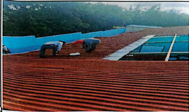
Foto N 1: desinstalación de lámina en mal estado del salón de clases de segundo grado.
