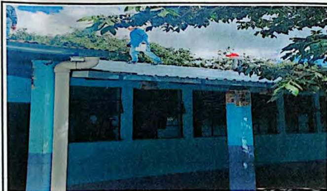
Foto N 3: Instalación de lámina en salón de primer grado.
