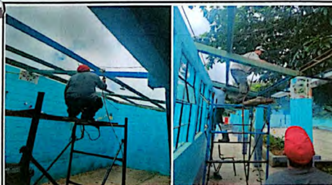
Foto N 5: Aplicación de pintura anticorrosiva a toda la estructura metálica.
