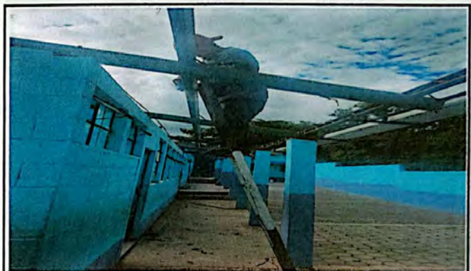
Foto N 4: Limpieza y lijado de la estructura metálica.
