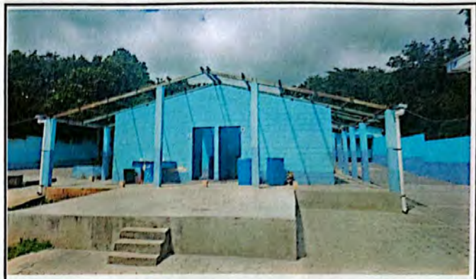
Foto N 2: Desinstalación completa de lámina en mal estado.
