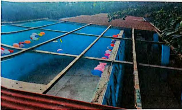
Foto N 7: Desinstalación de lámina en salón de tercer grado.
