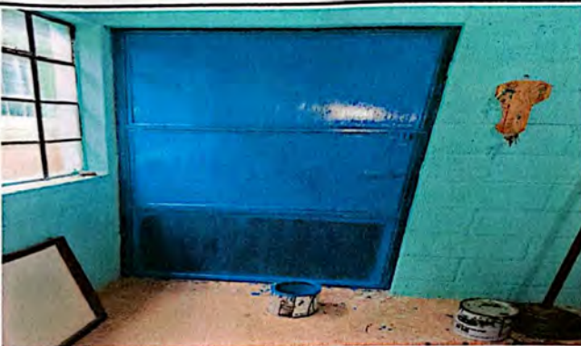
Foto N 9: aplicación de pintura anticorrosiva en puerta de la Dirección del establecimiento.
