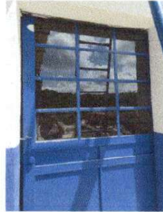
Foto 7: vidrio en ventanas y puerta de cocina
