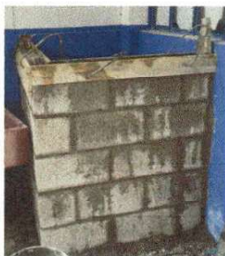
Foto 11: Cerco perimetral (para basurero)
