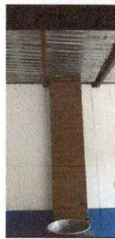
Foto 10: Sustitución de chimeneas
