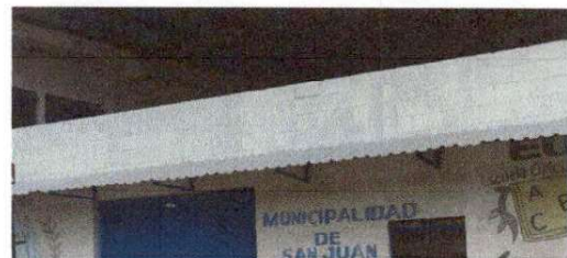
Foto 12: Muro Perimetral frente al establecimiento
