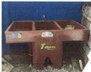
Foto 9: Sustitución de pila de concreto por pila plástica
