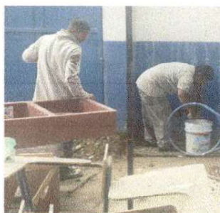
Foto 9: Sustitución de pila de concreto por pila plástica
