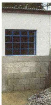
Foto 7: Vidrio en ventanas y puerta de cocina
