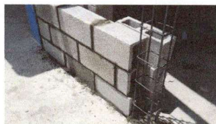
Foto 4: Remozamiento en el exterior de las paredes del establecimiento
