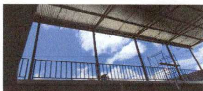
Foto 5: Suministro e instalación de canal
