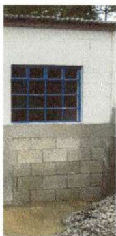
Foto 7: Vidrio en ventanas y puerta de cocina
