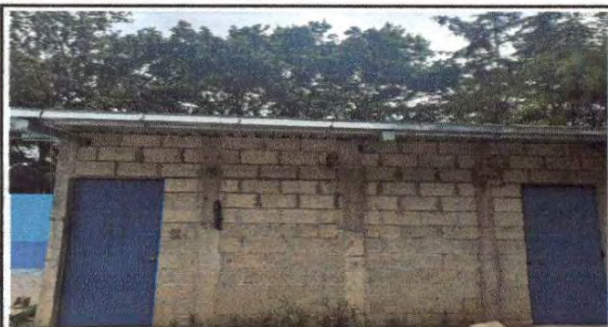
Foto 3: Instalación de puertas en sanitarios, canales y bajada de agua, estructura portante de metal y enlaminado con lámina troquelada calibre 26
