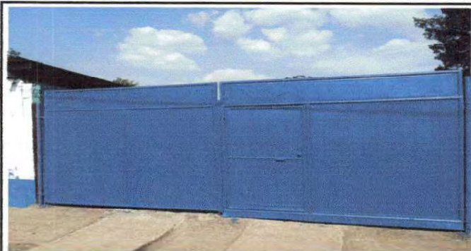
Foto 1: Reparación de portón de entrada al establecimiento.
