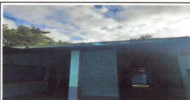
Foto 12: reparación de canales y nivelación de pescantes de canales.
