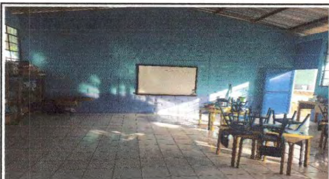
Foto 9: instalación de piso cerámico y pintura interior de aula de preparatoria.
