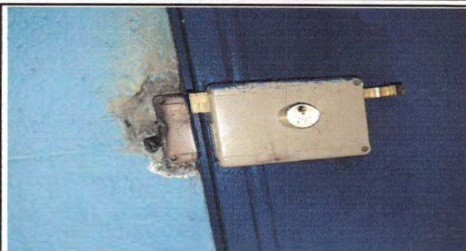
Foto 2: Cambio de chapa en la Dirección del establecimiento.
