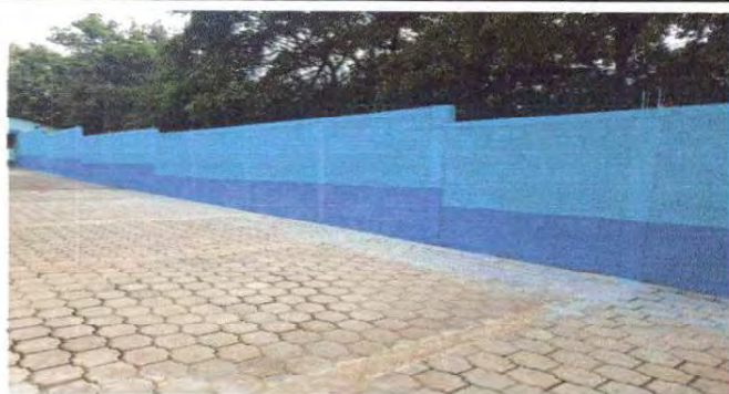
Foto 7: fundición de solera de humedad y pintura en muro perimetral patio izquierdo.
