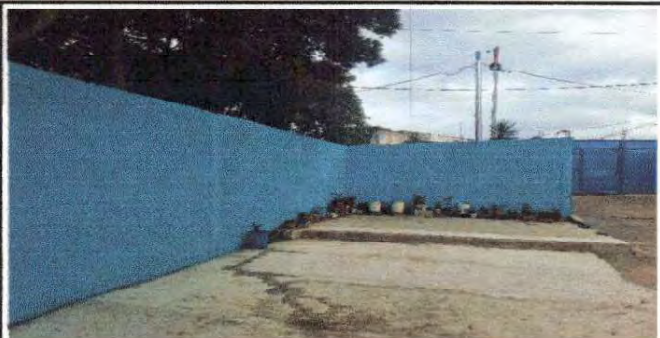
Foto 6: Fundición de losa de cemento en patio, reparación de losa de cemento, pintura muro perimetral lado derecho.
