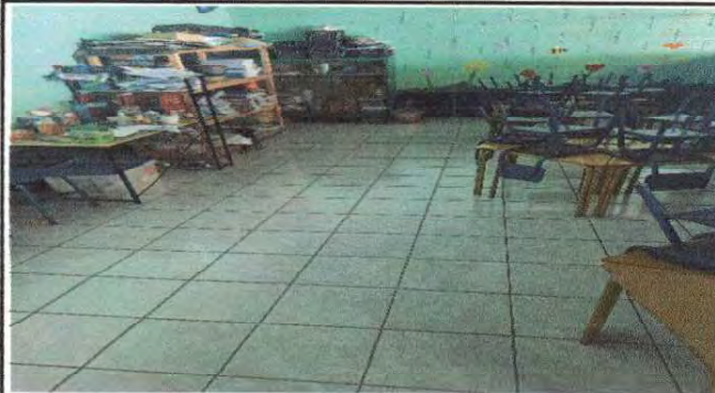
Foto 8: instalación de piso cerámico en aula de párvulos.
