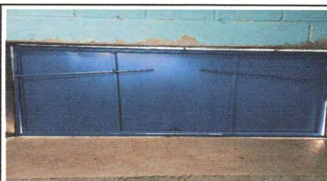
Foto 10: instalación de ventana de metal en cocina.
