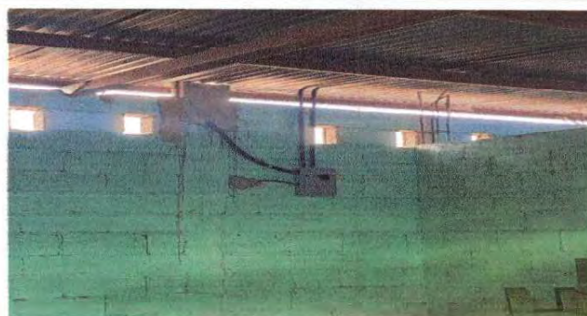
Foto 14: instalación, cambio de tablero y flipones, cambio de ducto eléctrico.
