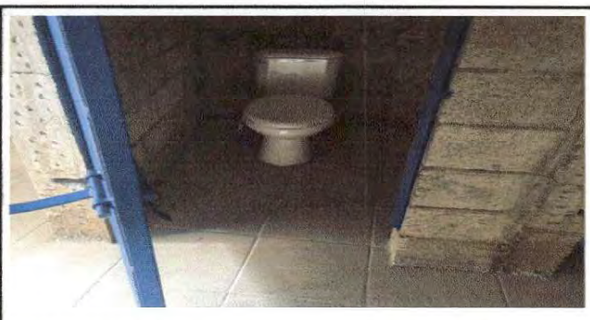
Foto 4: instalación de sanitarios, piso cerámico y puertas en sanitarios.
