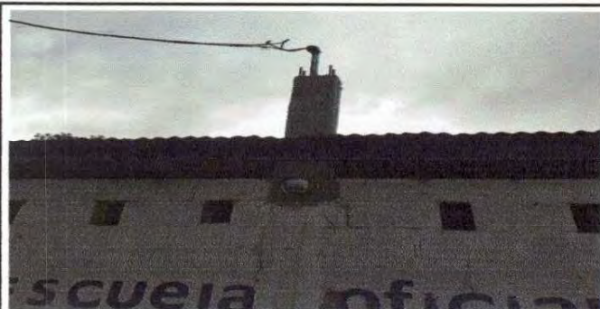
Foto 13: Instalación de acometida eléctrica.
