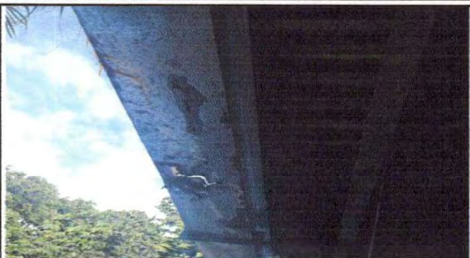
Foto 1: reparación y nivelación de canales aulas lado derecho
