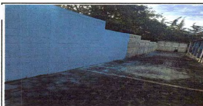
Foto 5: pintura exterior patio lado izquierdo
