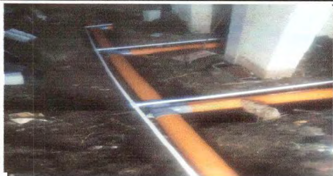
Foto1: Instalación de tubería de drenaje y agua en los módulos de sanitarios.
