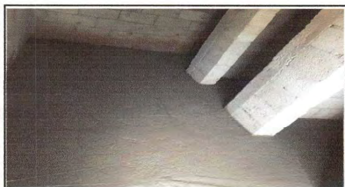
Foto 3: losa de cemento en area de sanitario para colocación de piso cerámico antideslizante
