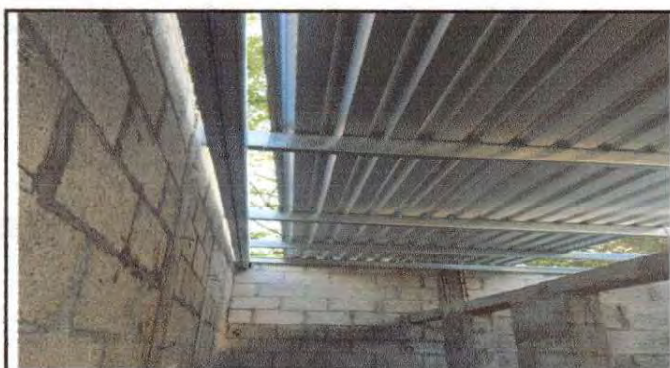
Foto 3: colocación de lámina en sanitarios
