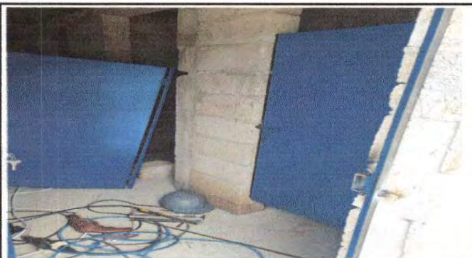
Foto 3: Instalación de puertas en sanitario de niñas
