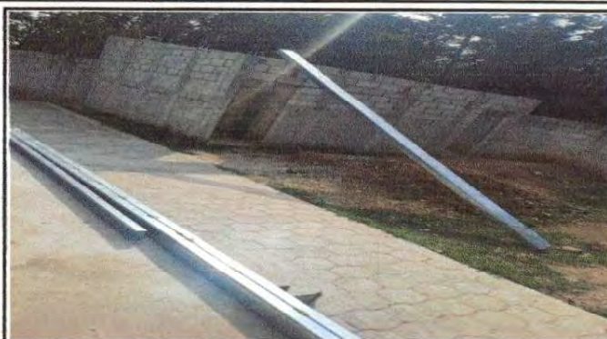
Foto 2: colocación de estructura metálica en sanitarios
