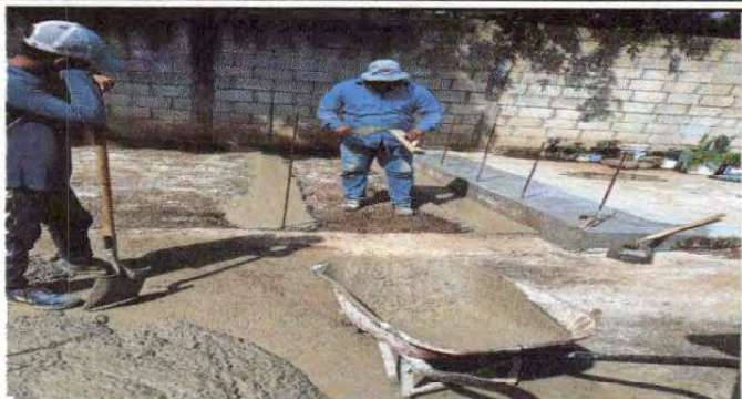
Foto1: fundición de losa de cemento en patio lado derecho
