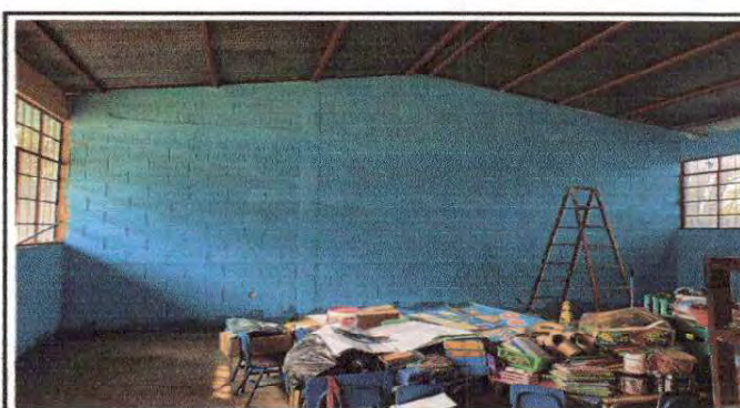
Foto 4: pintura interior aula de preparatoria
