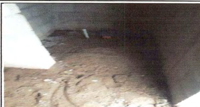
Foto 2: relleno y nivelación de suelo en area de sanitarios.
