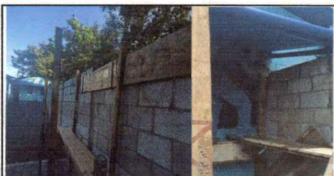
Foto 6: fundición de solera de humedad en muro perimetral
