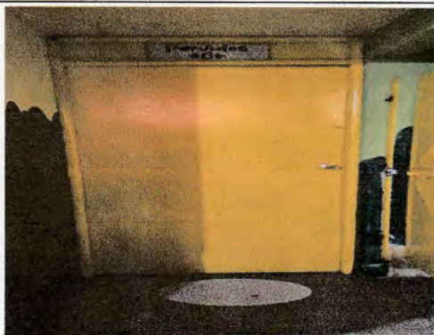
Foto 9: SUMINISTRO E INSTALACION DE PUERTA EN AULA DE ESCUELA
