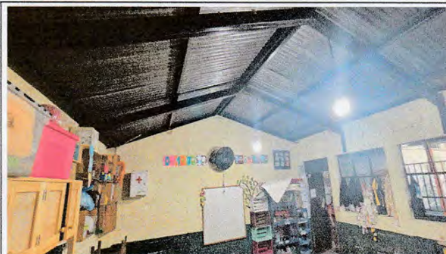
Fotografía 2: SUMINISTRO E INSTALACION DE CIELO FALSO EN AULA SEGUNDO NIVEL DEL CENTRO EDUCATIVO
