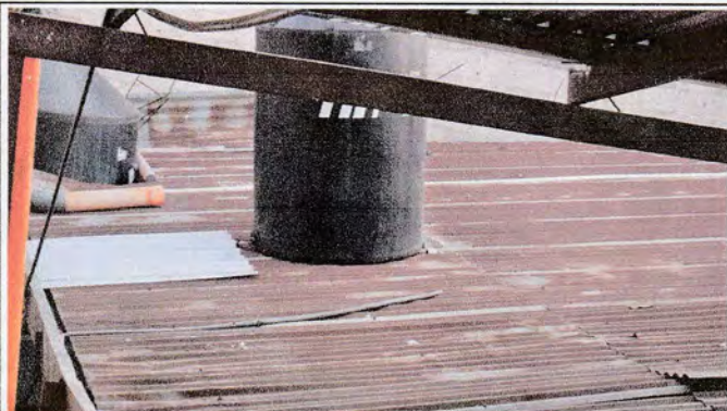
Foto7: . SUMINISTRO E INSTALACION DE LAMINA TROQUELADA CALIBRE 26 EN AULA DE CENTRO EDUCATIVO.
