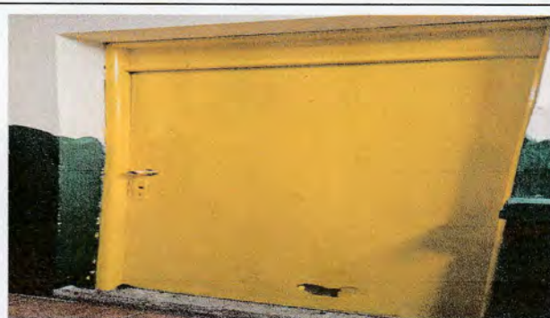
Foto10: COLOCACION Y SUMINISTRO DE PUERTA EN AULA DE CENTRO EDUCATIVO,
