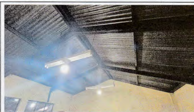
Fotografía 4: INSTALACION DE CIELO FALSO EN AULAS DE ESCUELA EVITAR ALTAS TEMPERATURAS TERMICAS.
