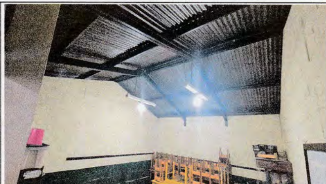
Fotografía 3: COLOCACION DE CIELO FALSO EN DIFERENTES AULAS SEGUNDO NIVEL
