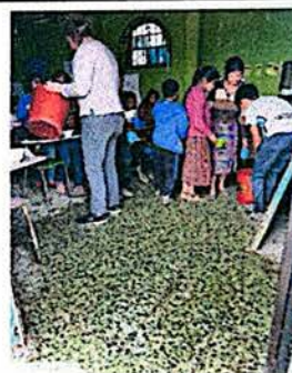
Foto 4: Colocación de piso de granito en salón de clases.
