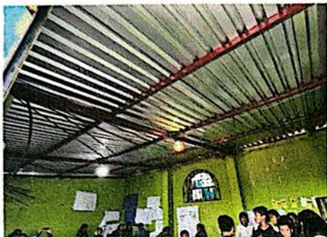
Foto 1: Mantenimiento a estructura de techo, incluye lijado y pintura mas instalación de lámina troquelada nueva.
