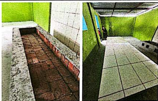
Foto 9: Fabricación Estufa tipo pollo y mesa de trabajo con top de azulejo.
