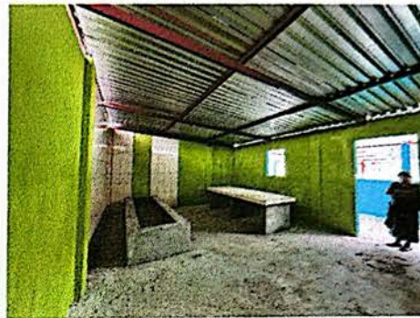
Foto 8: Vista general en ampliación de cocina.
