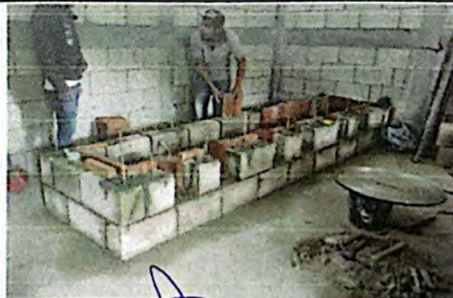
Foto 6: Fabricación de estufa artesanal con block y ladrillo.
