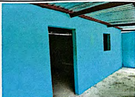
Foto 5: Levantado de muro en cocina + aplicación de repello + aplicación de pintura + suministro e instalación de techo.
