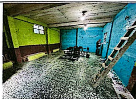
Foto 10: Suministro e instalación de piso tipo granito e salón de clases.
