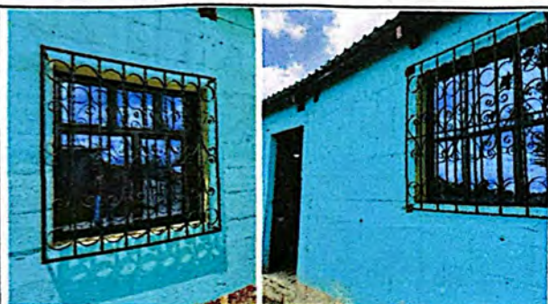
Foto 9: Mantenimiento a ventanas y balcones, incluyendo vidrios + aplicación de pintura en muros exteriores.
