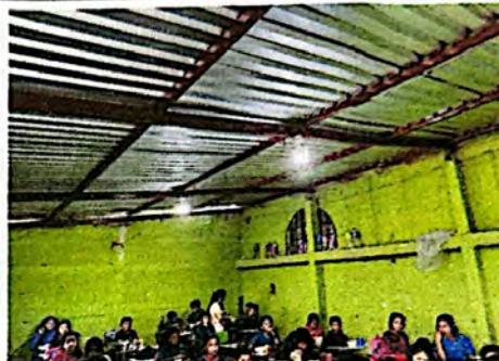
Foto 2: Suministro e instalación de lámina troquelada.
