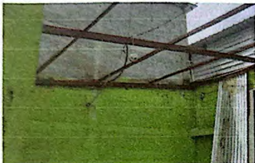
Foto 1: Se desmonta el techo de lámina en malas condiciones.
