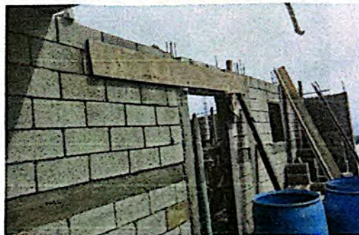
Foto 4: Levantado de muro, encofrado y fundición de soleras para cocina.
