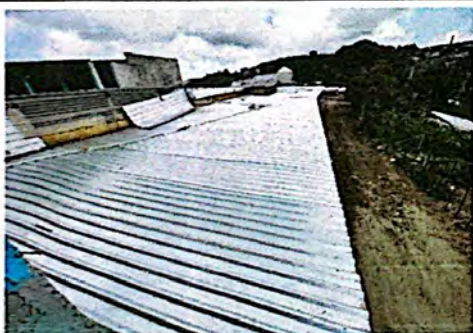
Foto 3: Vista desde la parte superior de techo de lámina.
