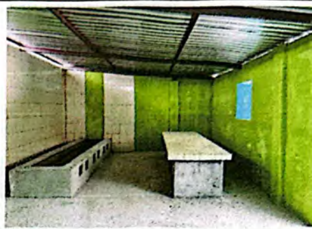
Foto 8: Vista general en ampliación de cocina.
