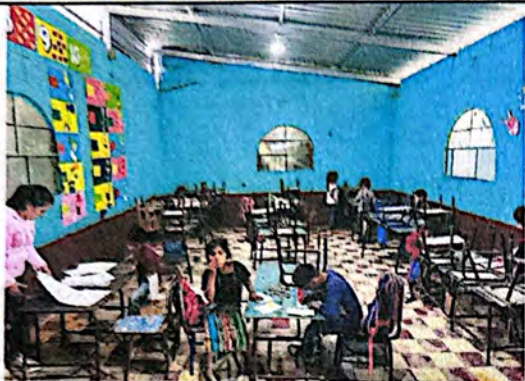
Foto 1: Salón al que se le cambiará el piso en el Modulo D
