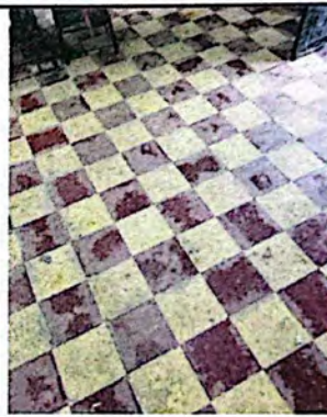
Foto 4: Con el cambio de piso se podrá realizar limpieza de manera mas profunda.
