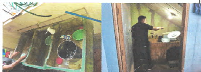
Foto 4: Espacio de pila de cocina a repellar y azulejar
