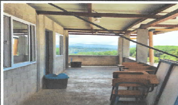
Foto 8: Instalación de Estructura Metálica (segundo nivel)
