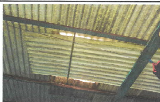
Foto 2: Área de la bodega que necesita sustitución de techado
