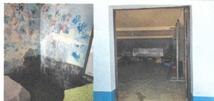
Foto 5: Salon que necesita reparacion por humedad
