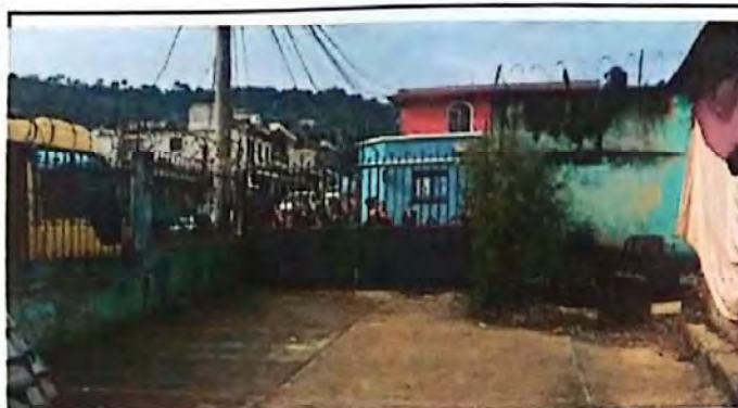
Foto 5: Sustitución de portón de metal
