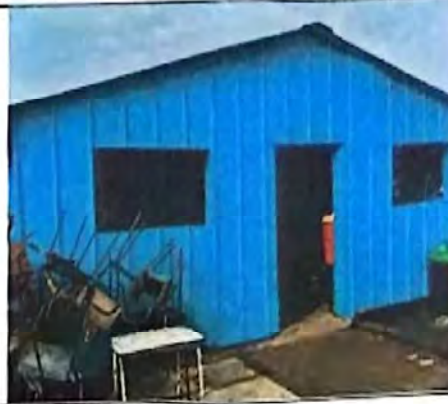
Foto 2: Instalación de ventanas
