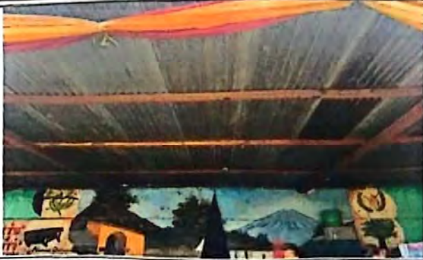
Foto 13: Sustitución de lámina galvanizada en escenario por lámina troquelada calibre 26
