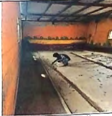
Foto 8: Tallado de paredes internas de salón
