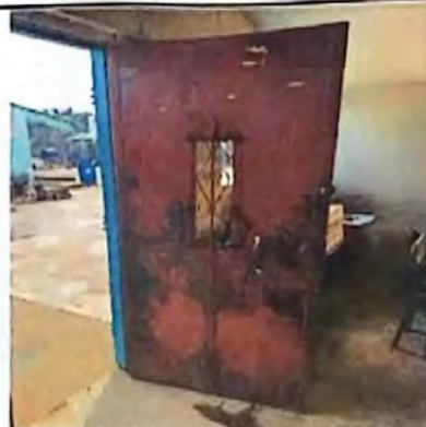
Foto 4: Reparación de puertas
