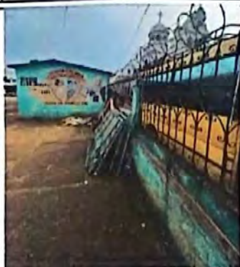
Foto 7: Tallado de muro perimetral, entrada principal
