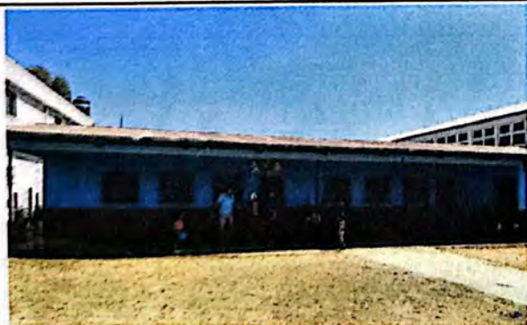
Foto 5: Se puede apreciar que el techo de lámina en la parte frontal del mojinete presenta oxidación y problemas de filtración en época de lluvia.
