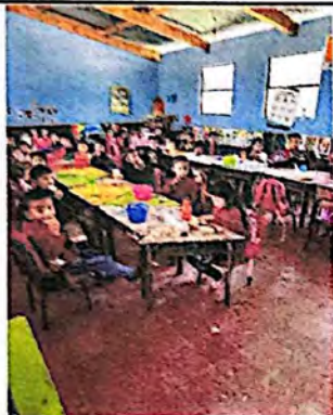
Foto 1: Los salones de clases cuentan con pisos deteriorados por el paso de los años.
