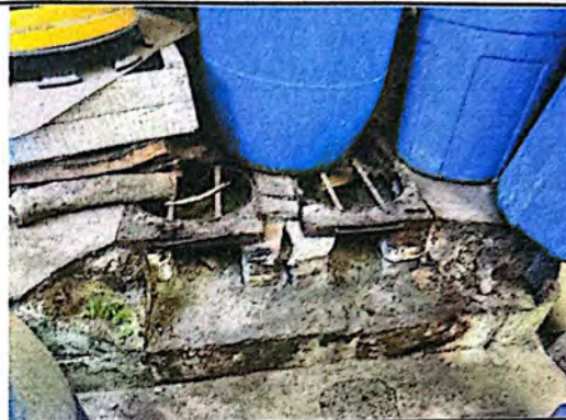
Foto 8: La actual plancha para la preparación de los alimentos se encuentra fuera de servicio y se deberá construir una nueva.
