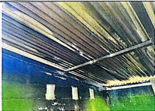
Foto 7: Se puede apreciar el deterioro en el techo de la cocina, por lo que es indispensable realizar el cambio del mismo.
