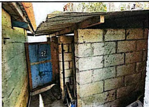
Foto 9: Los baños se encuentran en malas condiciones y la altura es muy baja y el techo se encuentra roto.
