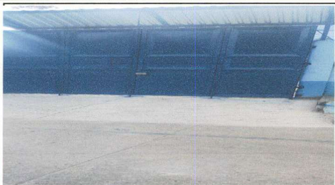
Foto 1: Sustrución de portón de la entrada del establecimiento y techado.
