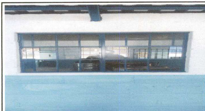
Foto 9: Sustitución de ventanas, para mejorar la ventilación e iluminación.
