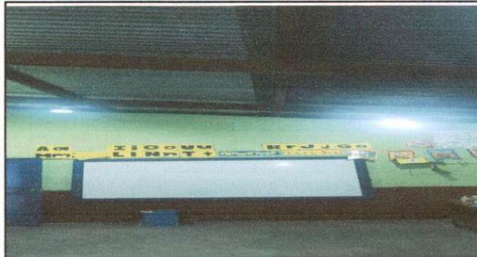
Foto 8: Sustitución de lamparas por focos
