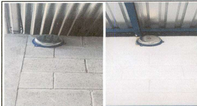
Foto7: Sustitución de timbres.
