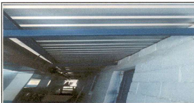
Foto 6: Sustrución de cubierta de lámina, por lámina troquelada aluzinc legitima.
