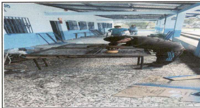
Foto 12: Mantenimiento de puertas, limpieza y pintura.
