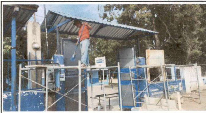
Foto 2: Sustrucción de portón de la entrada del establecimiento y techado para protección del portón.
