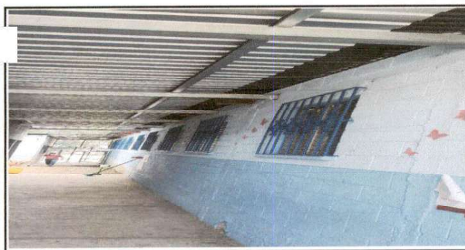
Foto 11: Mantenimiento de balcones, limpieza y pintura.
