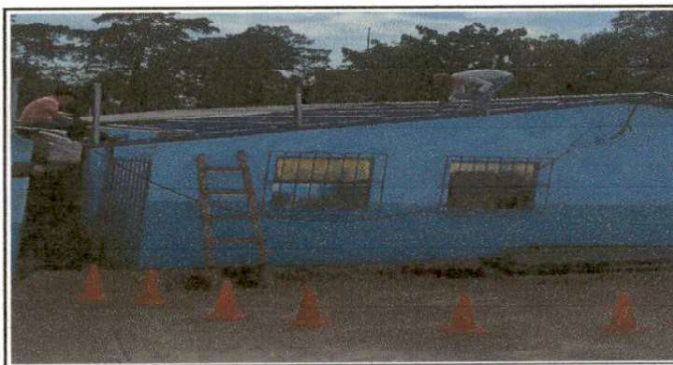
Foto 6: Sustrucción de cubierta de lámina, por lámina troquelada aluzinc legitima.
