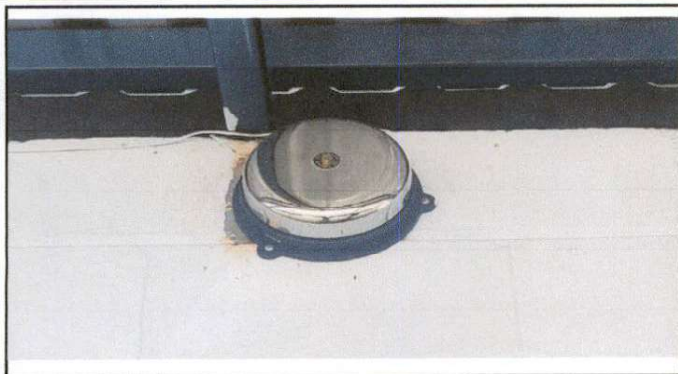
Foto 7: Sustrucción de timbres.
