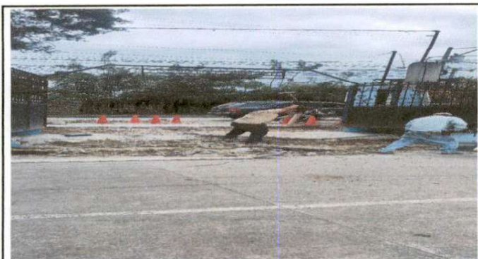
Foto 3: Sustrucción de gradas por rampa de losa.
