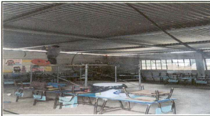
Foto 8: Sustrucción de lamparas por focos
