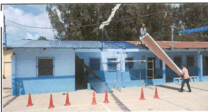
Foto 5: Sustrucción de cubierta de lámina, por lámina troquelada aluzinc legitima.
