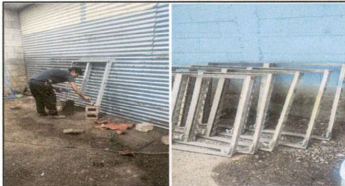
Foto 10: Mantenimiento de ventanas de paleta, limpieza de marco de aluminio, completar vidrios faltantes y cambio de controles inservibles.
