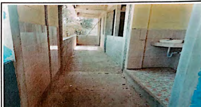
Foto 4: Esta imagen muestra el corredor del segundo nivel, espacio del salón No. 9, con torta de concreto, se sustituirá por piso cerámico.
