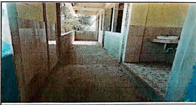
Foto 13: El salón necesita ventanales, terminación de la colocación de piso, ventanas, repello y cernido de paredes, así mismo la colocación de piso.
