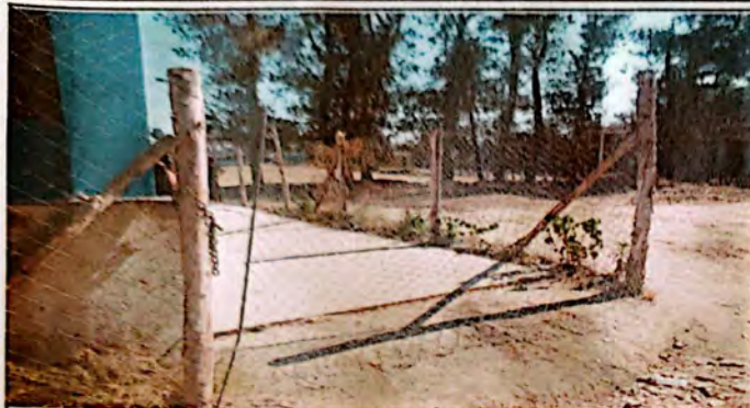
Foto 1: Esta imagen muestra la entrada y salida de la EODP Escuela Oficial de Párvulos, donde se realizará la sustitución del portón de malla.
