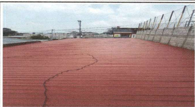
Foto1: CAMBIO TOTAL DE LÁMINA TROQUELADA
