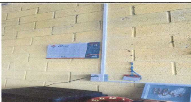
Foto 5: COLOCACIÓN DE CANALETA Y TOMACORRIENTES EN TODOS LOS SALONES
