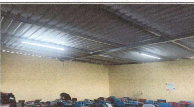
Foto 6: COLOCACIÓN DE LAMPARAS LED
