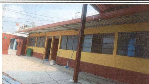
Foto 2: COLOCACIÓN DE CANALES EN TODO EL MÓDULO
