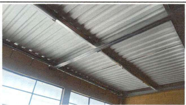
Foto 4: CAMBIO DE COSTANERAS EN TODO LOS 4 SALONES Y ÁREA DE SANITARIOS
