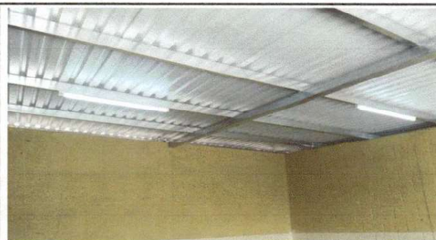
Foto 3 COLOCACIÓN DE LÁMPARAS LED
