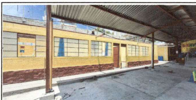
Foto 6: se quito todo el techo en mal estado
