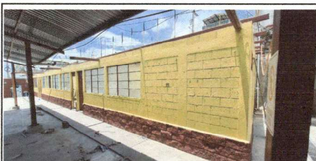
Foto 5: Parte de enfrente de los salones a los que se les cambiará techo
