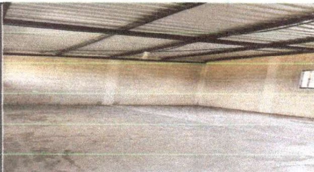
Foto 4: Remozamiento de techo de salón de clase y muros.
