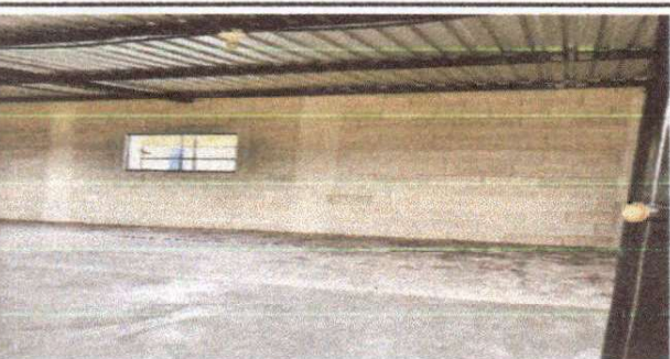
Foto 5: Remozamiento de muros de cocina y bodega.
