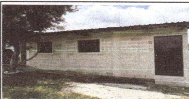
Foto 6: Terminado al 100% el cambio de muros y techo de aula
