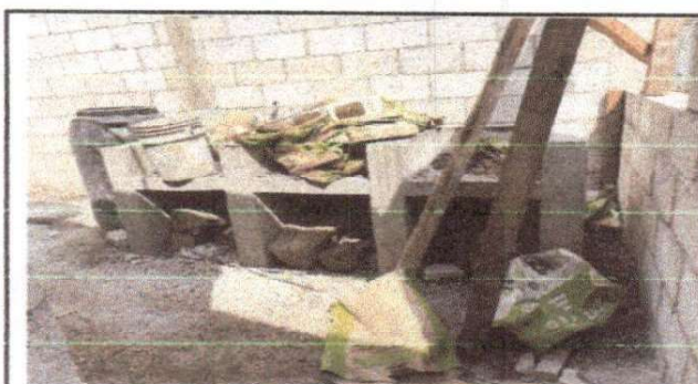
Foto 4: Remozamiento de la cocina, laminas por block y cambio de techo.
