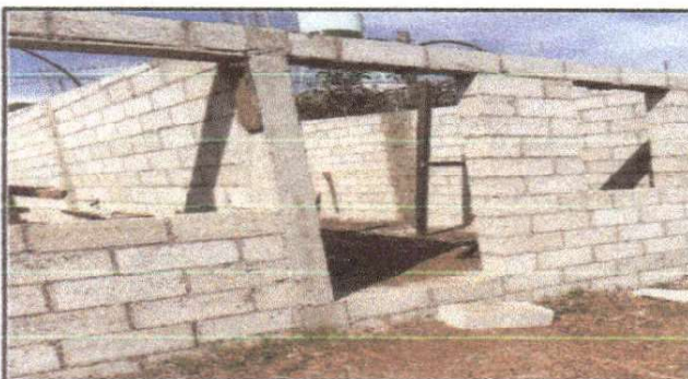
Foto 3: Remozamiento de muros de la bodega, que era de lámina
