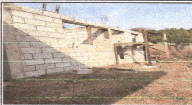
Foto1: Realización remozamiento de muros de la bodega
