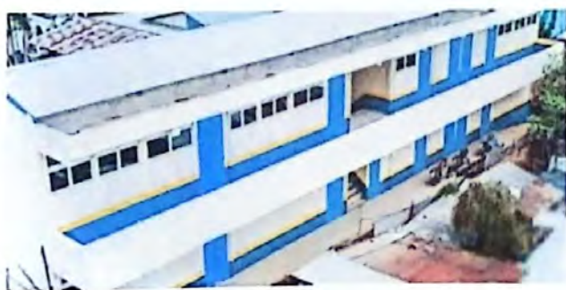
Foto 9: PASILLO (PLANTA ALTA)
