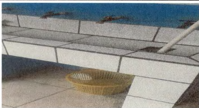
Foto 5. Corrección del drenaje del lavamanos de los servicios sanitarios del módulo I
