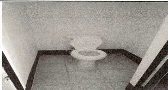
Foto 5. Cambiar los inodoros de los servicios sanitarios del módulo I
