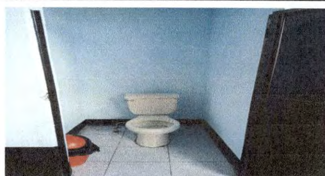
Foto 2. Remozamiento de servicios sanitarios del módulo II
