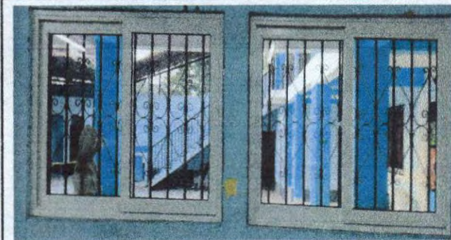
Foto 4. Cambio de ventanas de PVC
