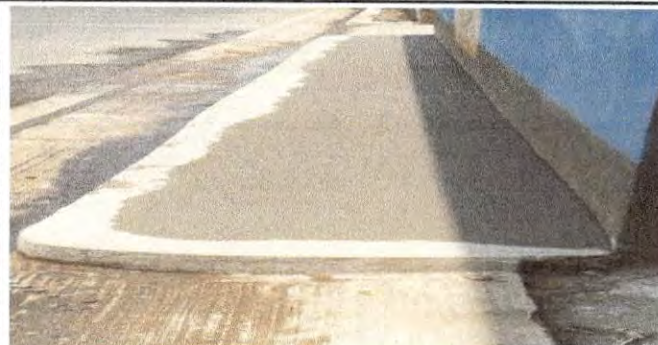
Foto 2. Banqueta de la escuela
