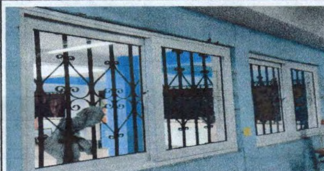
Foto 3. Cambio de ventanas de marco de metal por PVC.
