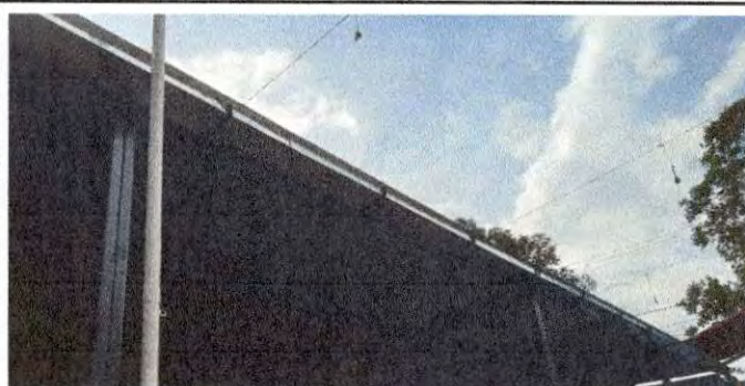
Foto 4. El cambio de canales de agua pluvial
