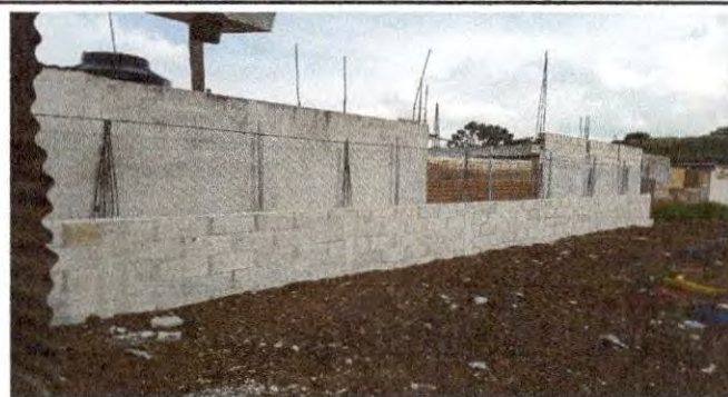
Foto 4. Remozamiento de una parte del muro, perimetral.
