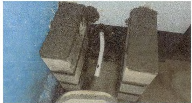
Foto 2. Colocación de la base del lavamanos por donde se ubica el mijitorio.
