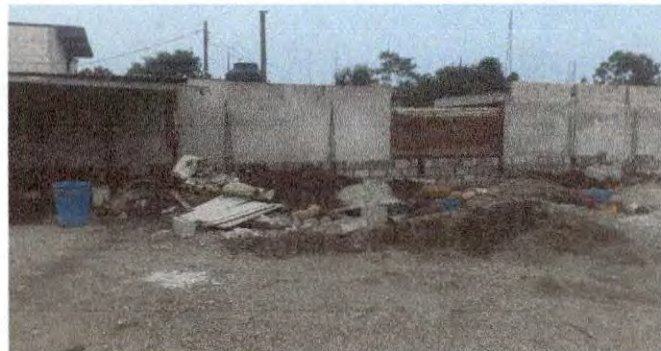
Foto 4. Remozamiento de una parte del muro, perimetral.
