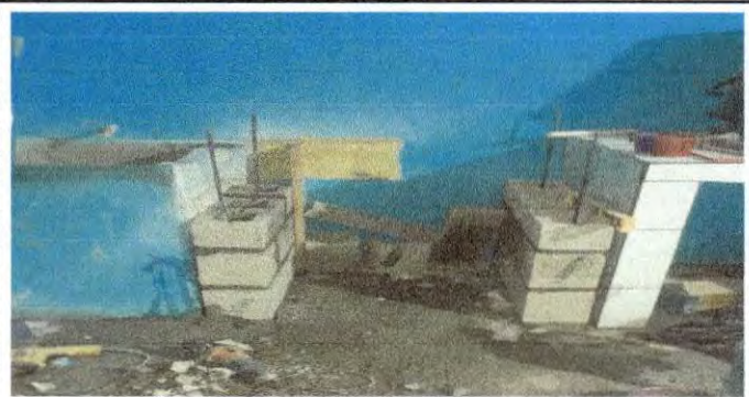
Foto 4. Pila de la cocina se amplió el lavadero del lado derecho y tampizado con azulejo
