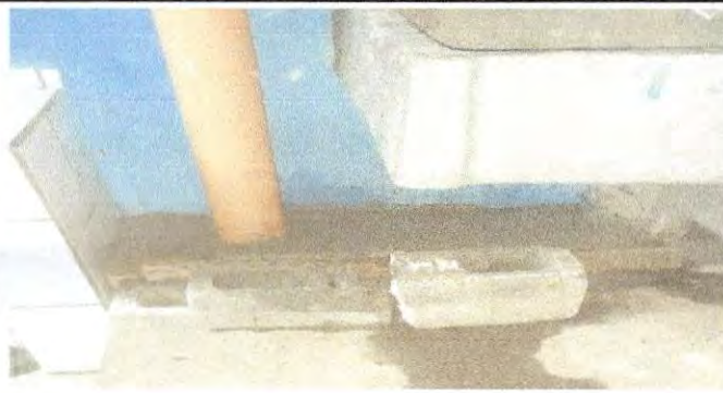
Foto 3. El cambio del drenaje del lavamanos de servicio sanitario del modulo I
