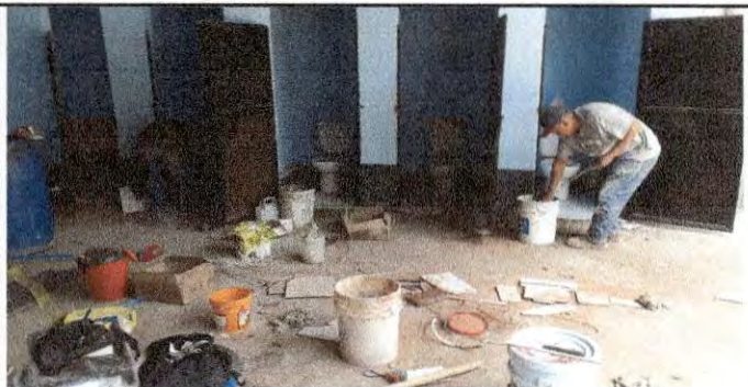
Foto 6. Remozando los servicios sanitarios del modulo II.
