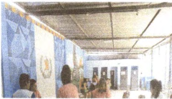
Foto 3. Remozamiento de costaneras del escenario
