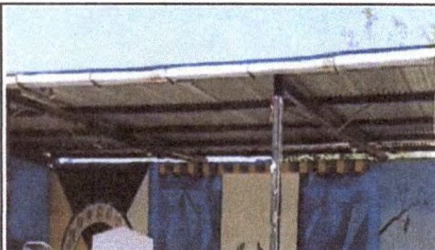
Foto 4. El cambio de canales de agua pluvial
