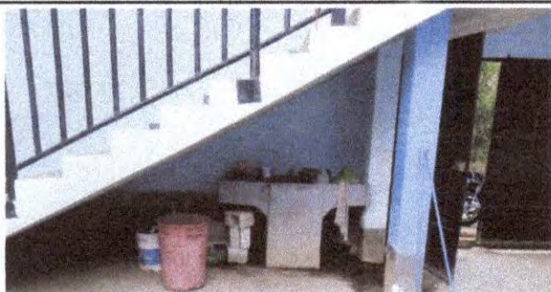
Foto 5. La pila quedo en un mal lugar no se puede utilizar los dos lavaderos uno esta tapado y el otro queda debajo de las gradass. Y se acumula agua en la entrada.
