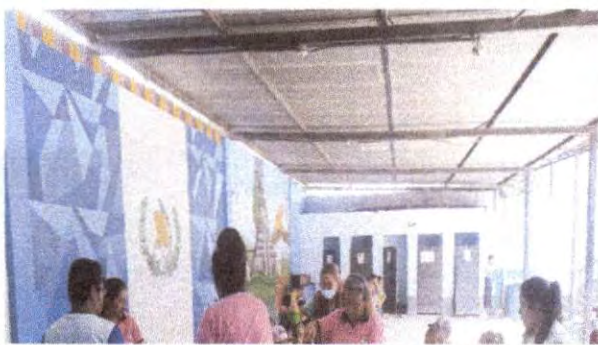
Foto 3. Remozamiento de costaneras del escenario
