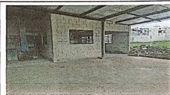
Foto 4: LOSA DE PATIO
