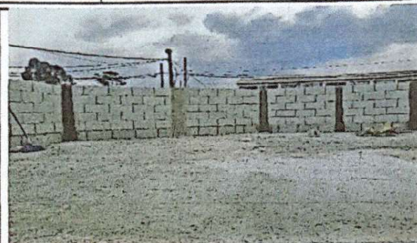
Foto 2: AMPLIACIÓN DE MURO PERIMETRAL
