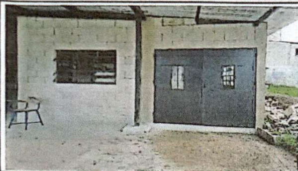
Foto 1: REMOZAMIENTO DE COCINA
