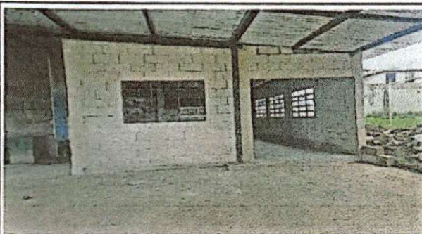
Foto 3: TECHADO DE LAMINA Y ESTRUCTURA
