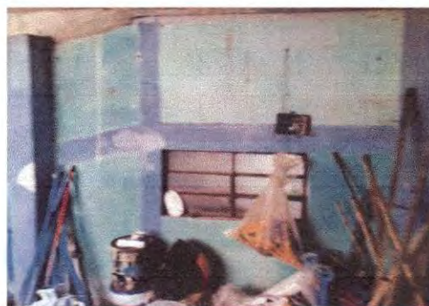
Foto 4: En la presente imagen del modulo 1 se observa la pared a la cual se le aplicará sernido, repello y pintura.
