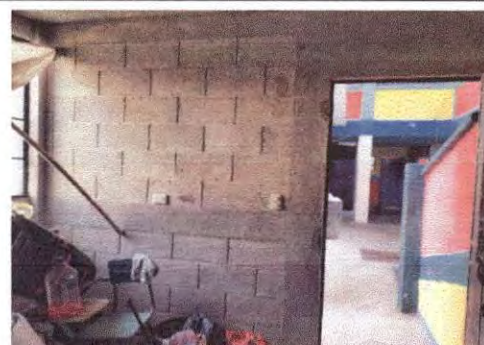
Foto 6: En la presente imagen del modulo 1 se observa la pared a la cual se le aplicará sernido, repello y pintura.
