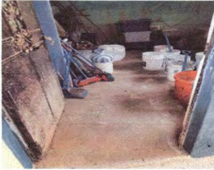
Foto 7: En la presente imagen del modulo 1 se observa la torta de cemento de la cocina que se sustituirá por piso de granito.
