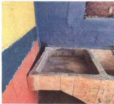
Foto 9: En la presente imagen del modulo 1 se observa la pila en mal estado que se sustituirá.
