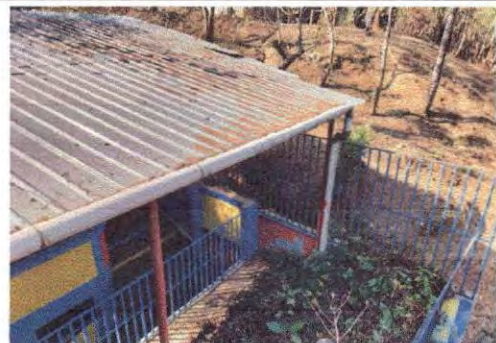
Foto 18: En la presente imagen del modulo 2 se observa la bajada de agua pluvial que se sustituirá por canal de metal.
