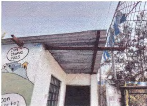
Foto 15: En la presente imagen del modulo 2 se observa la lámina galvanizada de la dirección que se sustituirá con lámina troquelada.
