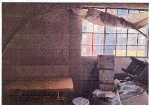
Foto 5: En la presente imagen del modulo 1 se observa la pared a la cual se le aplicará sernido, repello y pintura.
