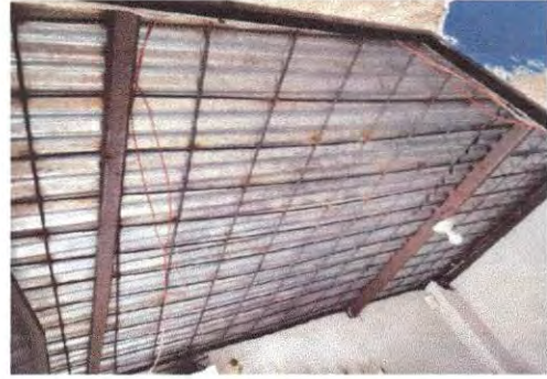
Foto 14: En la presente imagen del modulo 2 se observa la lámina galvanizada de la dirección que se sustituirá con lámina troquelada.
