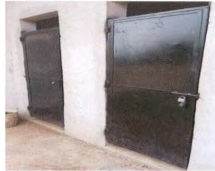
Foto 2: PUERTAS INSTALADAS PARA SANITARIOS 1,2,3 Y 4
