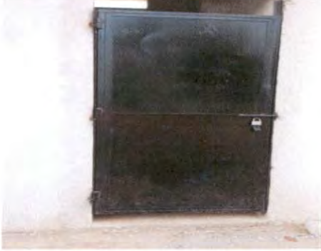
Foto 1: PUERTA INSTALADA PARA SANITARIOS 1,2,3 Y 4
