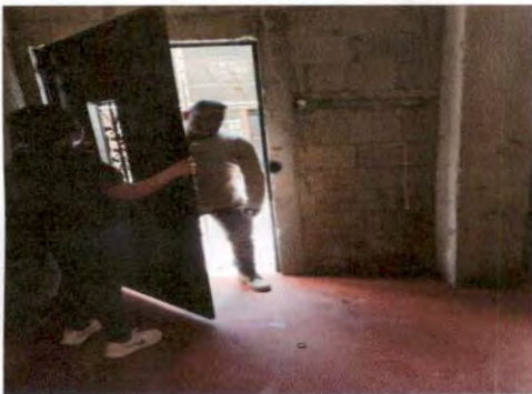
Foto 3: PUERTA INSTALADA PARA SALÓN 4
