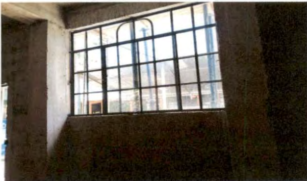
Foto 5: VENTANA INSTALADA PARA SALÓN 4
