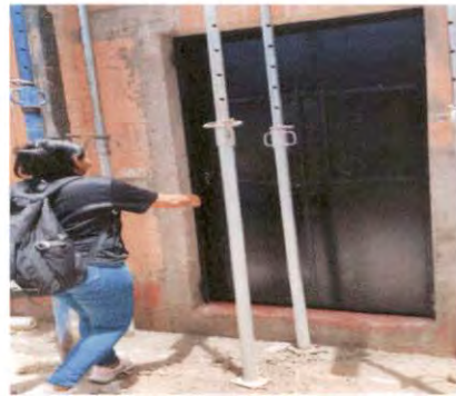
Foto 4: COLOCACIÓN DE PUERTAS PARA SANITARIOS 1,2,3 Y 4
