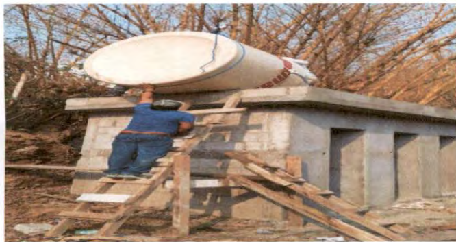
Foto 3: COLOCACIÓN Y REPARACIÓN DE CISTERNA/DEPÓSITO DE AGUA
