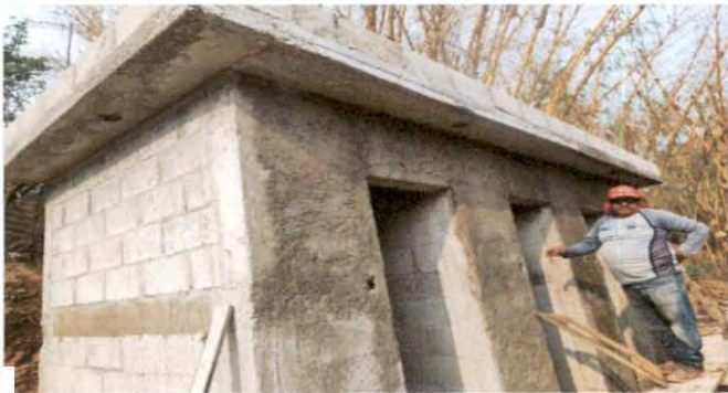
Foto 1: REPELLO DE PAREDES DE SANITARIOS 1, 2, 3 Y 4
