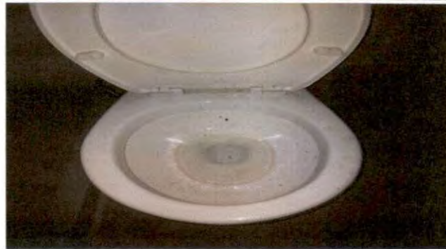
Foto 2: INSTALACIÓN DE TAZAS PARA SANITARIOS 1,2,3 Y 4
