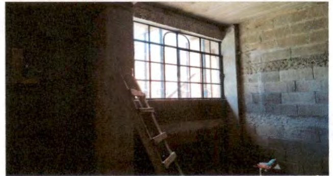
Foto 6: VENTANA INSTALADA PARA SALÓN 4
