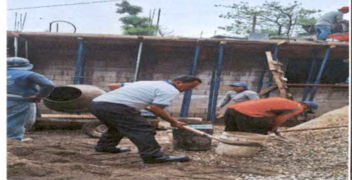
Foto 2: PREPARACIÓN DE CONCRETO PARA FUNDICIÓN DE LOZA EN EL SALÓN 4
