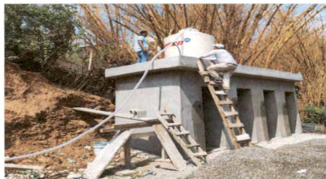
Foto 4: INSTALACIÓN DE TUBERIAS PARA CISTERNA/DEPÓSITO DE AGUA
