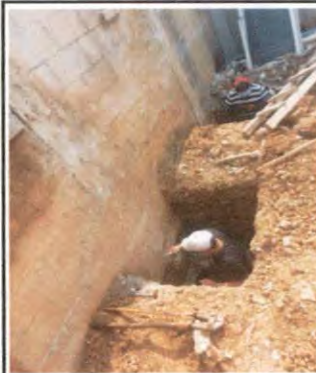
Foto 2: EXCAVACIÓN DE ZAPATA PARA COLOCAR COLUMNAS DE REFUERZO PARA LOZA EN EL SALÓN 4
