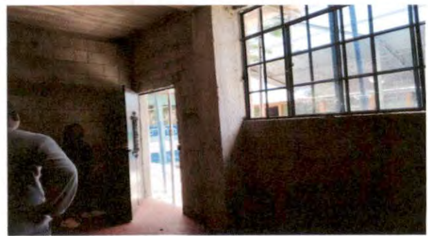
Foto 6: COLOCACIÓN DE VENTANAS PARA SALÓN 4
