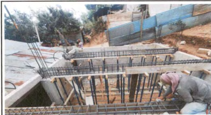
Foto 4: COLOCACIÓN DE ARMADURA DE COLUMNAS PARA LOZA DE SALÓN 4
