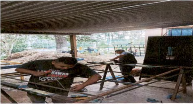
Foto 1: ELABORACIÓN DE PUERTAS PARA SANITARIOS Y SALÓN 4
