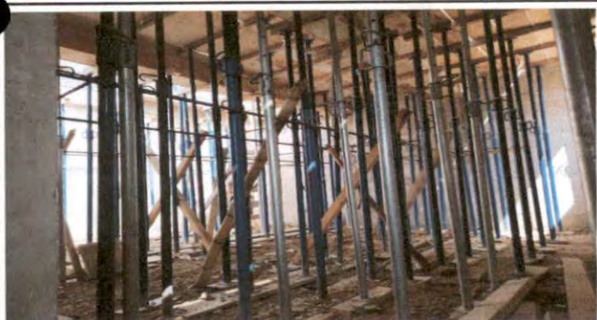
Foto 5: COLOCACIÓN DE TRIKET PARA LOZA DE SALÓN 4
