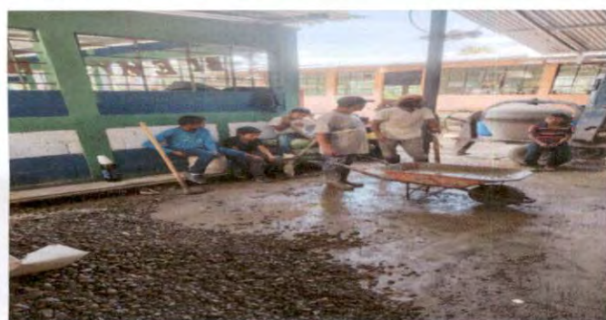
Foto 3: PREPARACIÓN DE CONCRETO PARA FUNDICIÓN DE TORTA EN SALÓN 4
