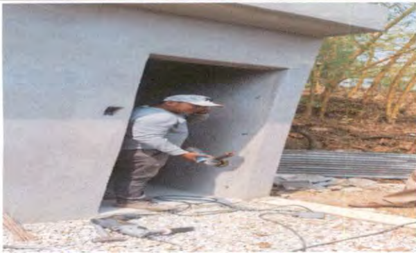
Foto 3: MEDICIÓN DE PUERTAS PARA SANITARIOS 1,2,3 Y 4
