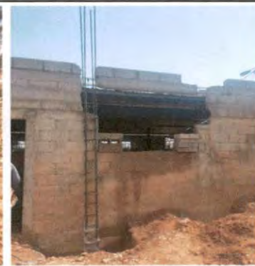
Foto 2: EXCAVACIÓN DE ZAPATA PARA COLOCAR COLUMNAS DE REFUERZO PARA LOZA EN EL SALÓN 4
