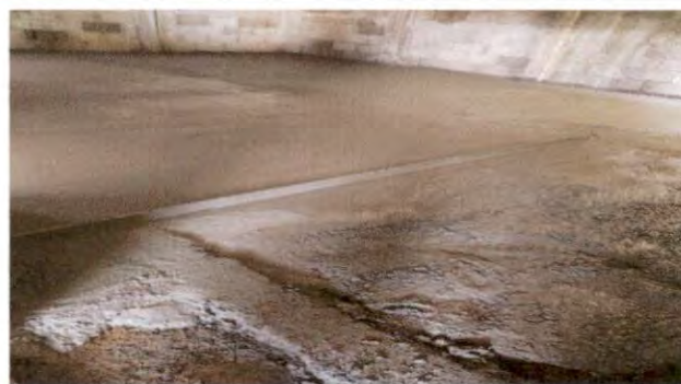
Foto 4: FUNDICIÓN DE TORTA DE CONCRETO PARA SALÓN 4
