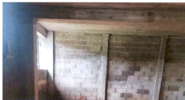
Foto 2: TALLADO DE PAREDES RÚSTICAS
