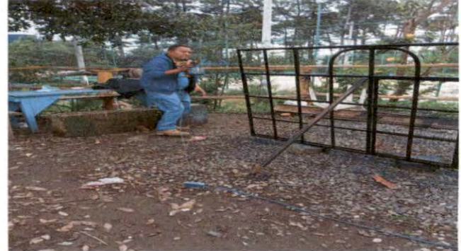
Foto 2: ELABORACIÓN DE VENTANAS PARA SALÓN 4
