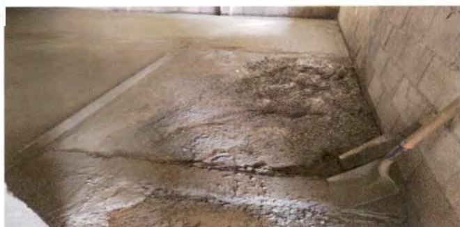
Foto 5: FUNDICIÓN DE TORTA DE CONCRETO PARA SALÓN 4
