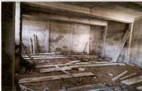
Foto 1: PREPARACIÓN DE TIERRA COMPACTADA PARA TORTA DE CONCRETO DE SALÓN 4
