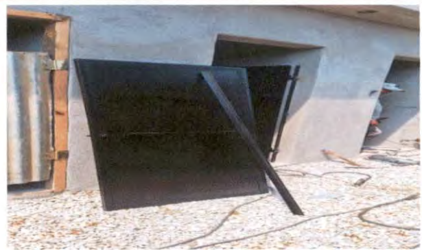
Foto 4: COLOCACIÓN DE PUERTAS PARA SANITARIOS 1,2,3 Y 4
