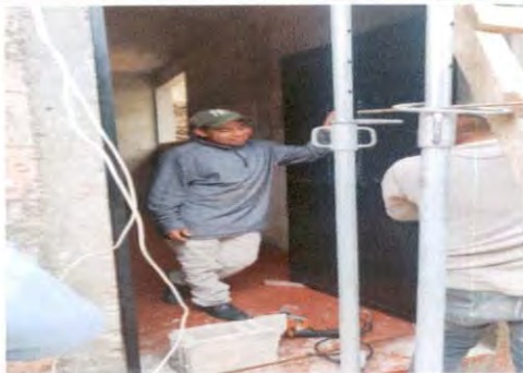
Foto 5: COLOCACIÓN DE PUERTA SALÓN 4
