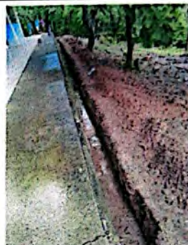
Foto 2: Zanqueo para fabricación de muro mampostería reforzada.
