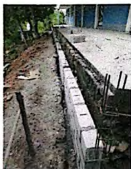
Foto 3: Levantado de muro de mampostería reforzada con columnas ubicadas cada 1.50 metros.
