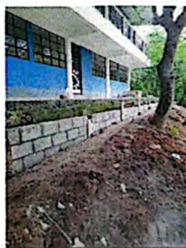
Foto 4: Muro de mampostería reforzada.
