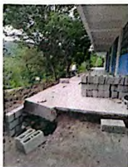
Foto 5: Proceso de fabricación de muro.
