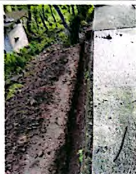
Foto 1: Proceso de zanqueo para realización de levantado de muro de contención.
