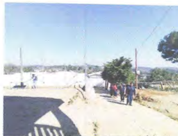
Foto 12: VISTA FRONTAL A ENTRADA DE ESTABLECIMIENTO DONDE SE REALIZARA LA INSTALACIÓN DE ESTRUCTURA METALICA Y LAMINA TROQUEADA
