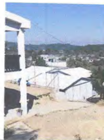
Foto 10: VISTA LATERAL PARTE ALTA DONDE SE LEVANTARAN COLUMNAS DE METAL
