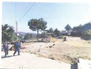
Foto 7: VISTA LATERAL DERECHA DONDE SE FABRICARA EL PISO TORTA DE CONCRETO
