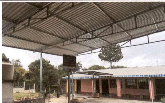
Foto 4: Cubierta de lámina en patio central
