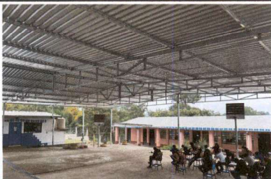
Foto 3: Cubierta de lámina en patio central
