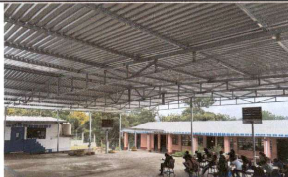
Foto 2: Cubierta de lámina en patio central
