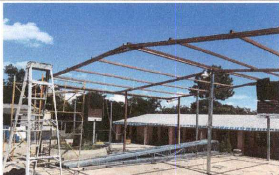
Foto 1: Desmontaje de lámina existente
