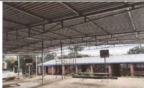
Foto 4: Instalación de lámina troquelada
