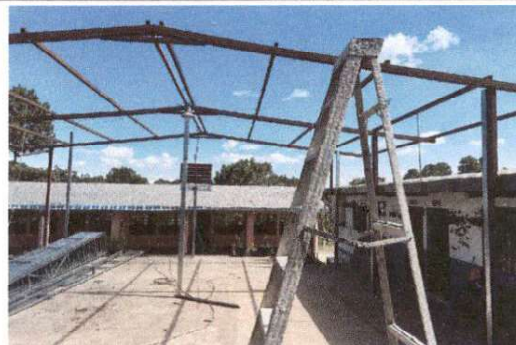
Foto 2: Refuerzo de estructura metálica en los laterales
