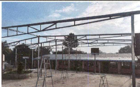
Foto 3: Refuerzo en la parte central de la estructura metálica
