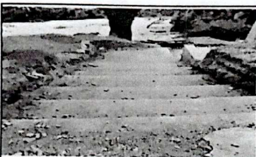
Foto 5: Gradas terminadas para uso de aula 1.
