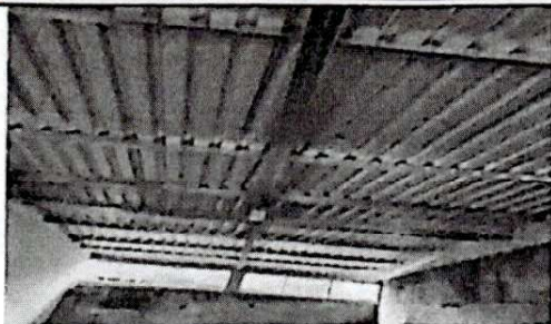
Foto 1: Techo terminado aula 4.
