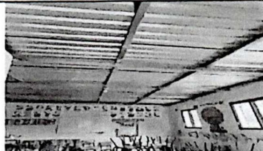
Foto 2: Techo terminado aula 5.
