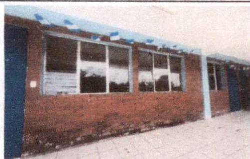
Foto 5: Debido al tema de seguridad y que el establecimiento carece de muro perimetral, es necesaria la colocación de balcones en todas las ventanas del primer nivel.
