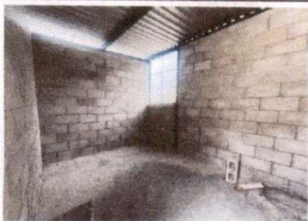
Foto 7: Cernido de paredes de interior de cocina. Sustitución de piso de torta de concreto por piso de granito.
