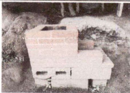
Foto 9: Sustitución de estufa rural completa.
